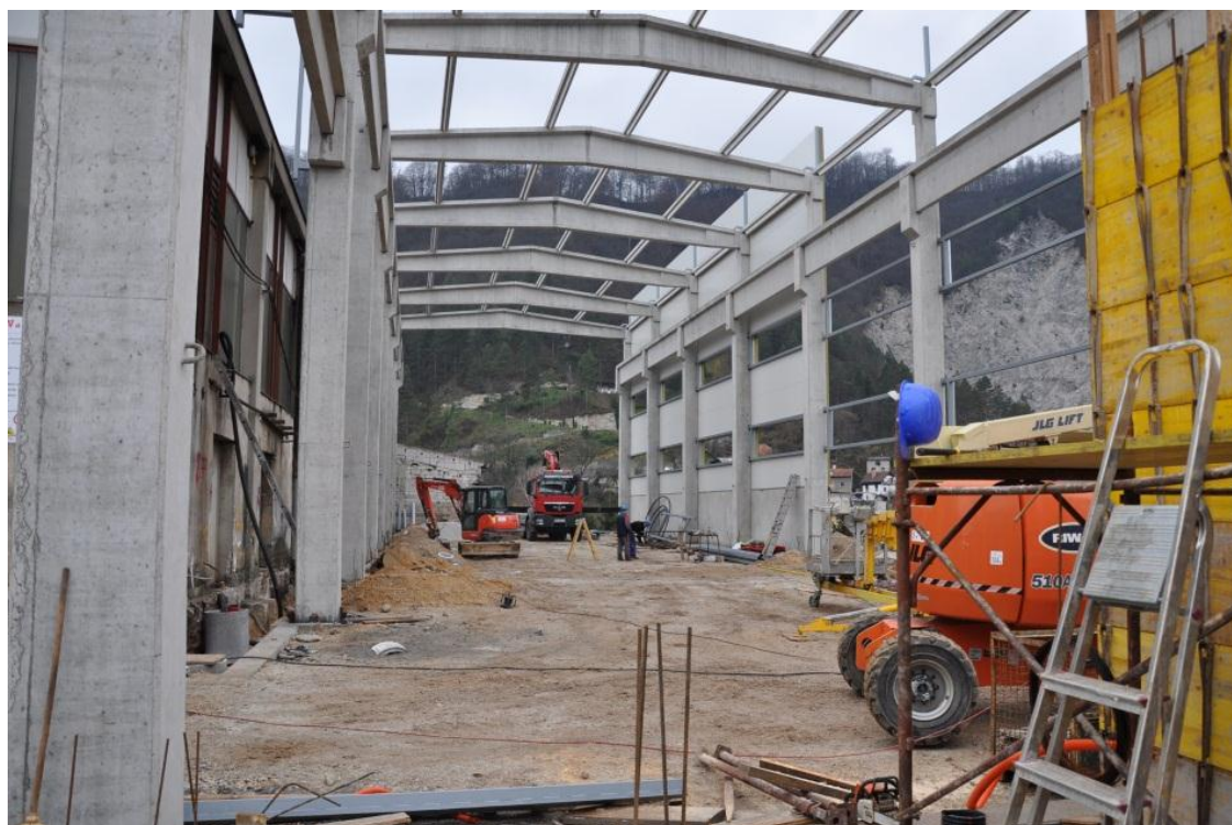
Slika 7: Objekt med gradnjo
