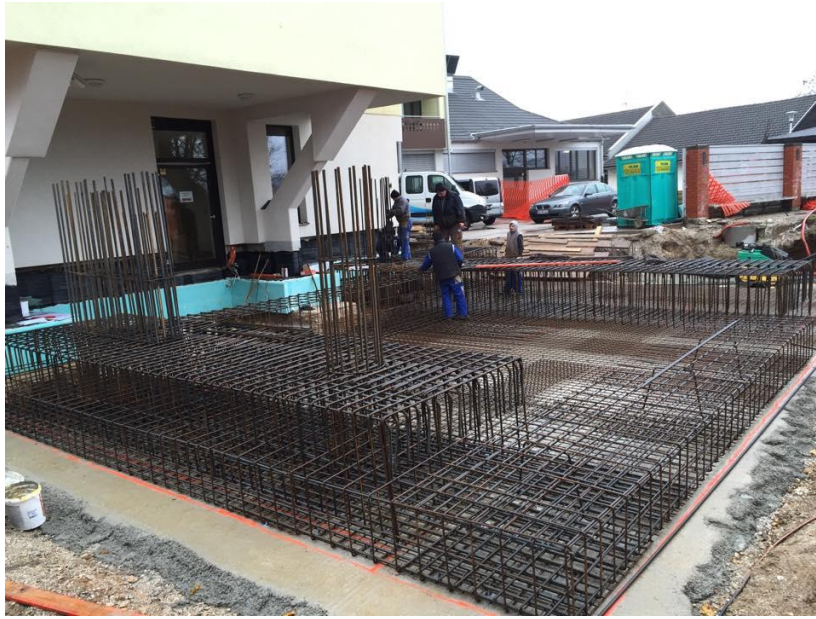
Slika 18: Armiranje temeljne plošče
