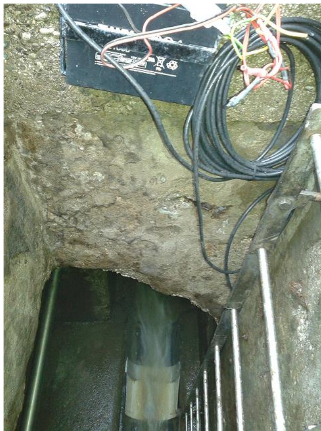
Slika 13: Merilno mesto za meritve pretoka.
