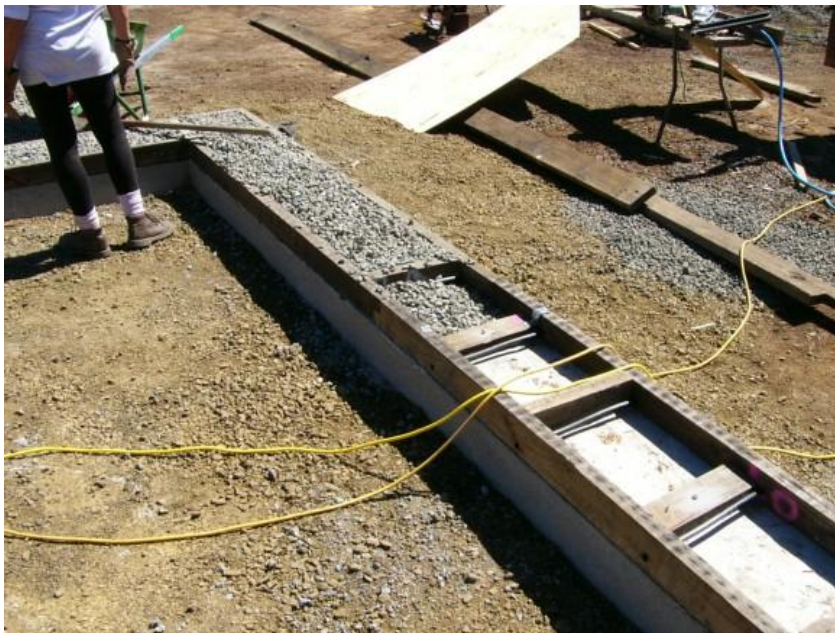
Slika 6: Stik med slamnatimi balami in temelji (Huff 'n' Puff Constructions, 2016).
