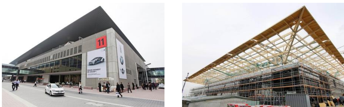
Slika 44: Razstavna hala Trade Fair Hall 11 z leseno strešno konstrukcijo [36].
