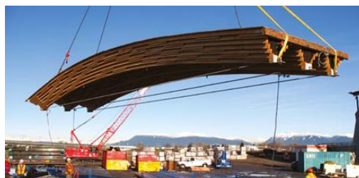
Slika 89: Dvigovanje WoodWave strešnih panelov [58].
