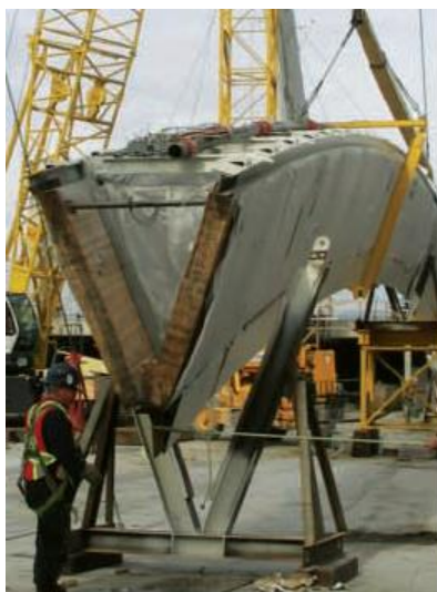
Slika 86: Hibridni ločni nosilec [52].
