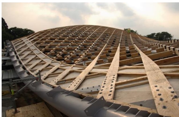
Slika 141: Robni jekleni podporni okvir [97].
