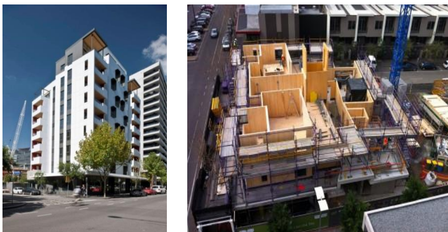
Slika 9: Večnadstropna stavba Forte iz CLT [19].
