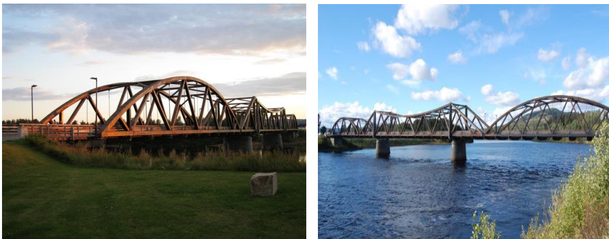
Slika 149: Lesen palični most Flisa [104].
