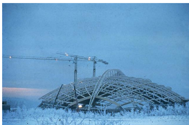
Slika 81: Lesena konstrukcija med gradnjo [50]
