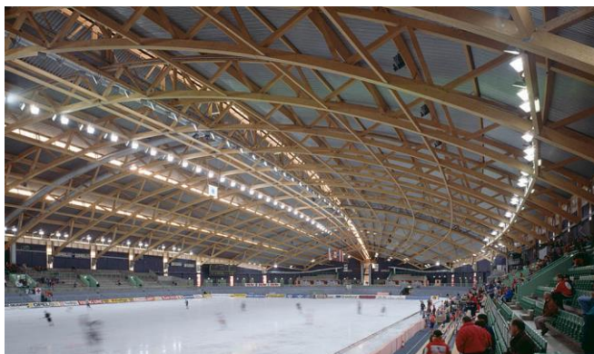
Slika 82: Notranjost lesene športne dvorane z jasno vidnimi bočnimi podporami [50].
