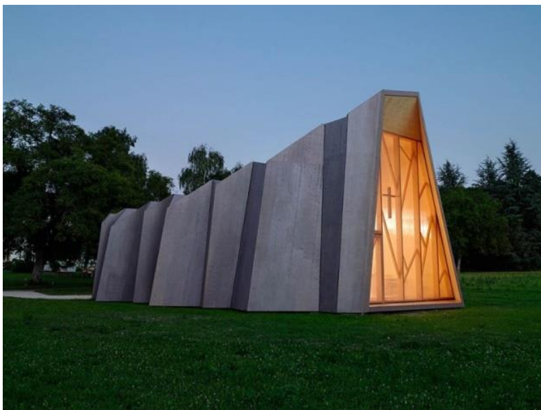
Slika 93: Primer zložene lesene konstrukcije iz CLT plošč [64].
