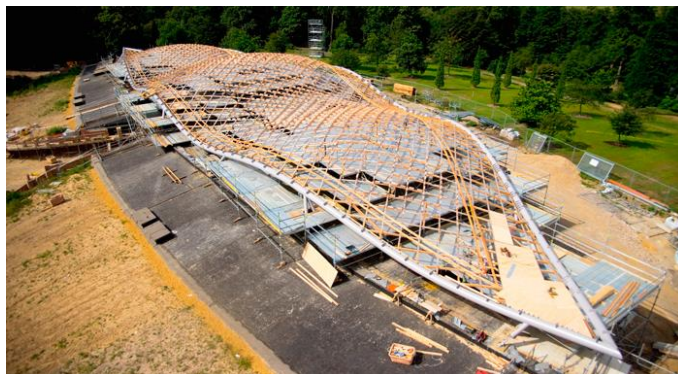
Slika 139: Strešna konstrukcija med gradnjo z začasnimi gradbenimi odri [65].
