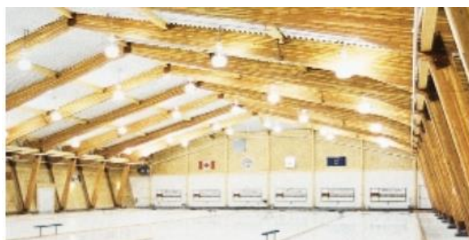
Slika 68: Primer športne dvorane za curling, iz ukrivljenih lepljenih okvirjev, Calgary, Kanada [46].
