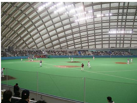
Slika 117: Levo, prostorsko leseno paličje kupole glede na daljši razpon [85].
