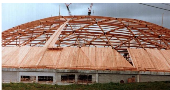
Slika 113: Gradnja lesenega zunanjega ovoja strešne konstrukcije [78].
