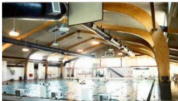
Slika 64: Uporaba ukrivljene okvirne konstrukcije pri kopališkem objektu [45].
