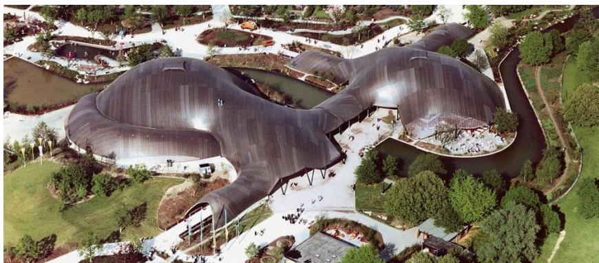
Slika 130: Pogled iz zraka na Mannheim Multihalle [92].
