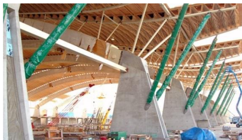
Slika 87: Podporna armiranobetonska konstrukcija [56].
