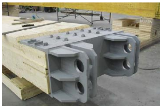
Slika 159: Transportna spoja – levo na zgornji pasnici, desno na spodnji pasnici [112].
