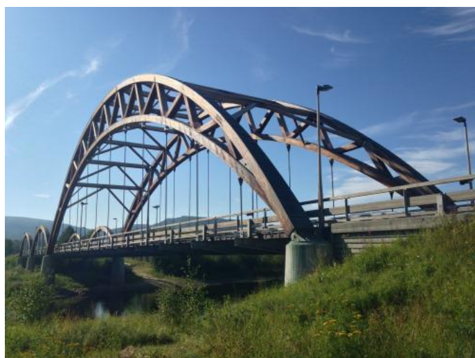
Slika 155: Glavni palični lok mosta Tynset z vidno zavarovalno konstrukcijo in razširitvijo zgornjega pasu [109].
