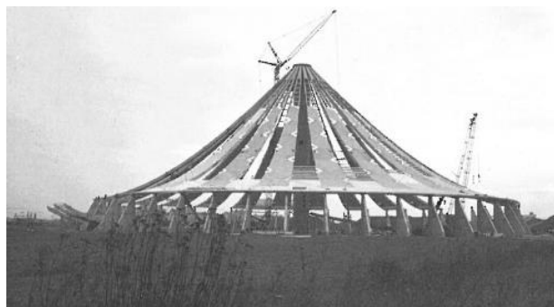
Slika 121: Lesena konstrukcija viseče lupine na Dunaju [90].
