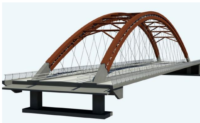
Slika 143: Steien Bridge z ločnim nosilnim sistemom in poševnimi vešali [101].
