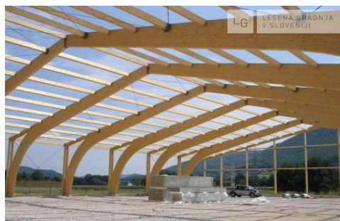
Slika 161: Tročlenska okvirna lesena konstrukcija športne dvorane Banex [114].
