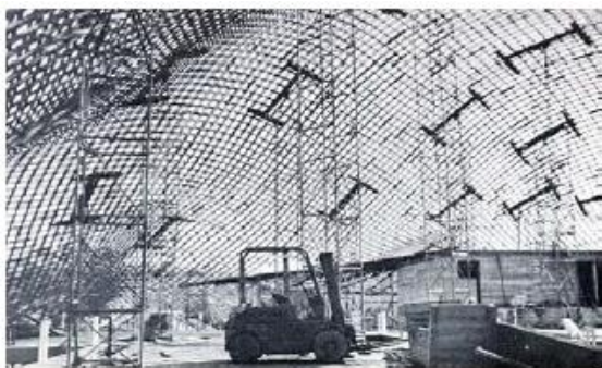
Slika 135: Levo – dvigovanje mreže s pomočjo viličarjev, desno – stebrni odri in vmesna opora [65].
