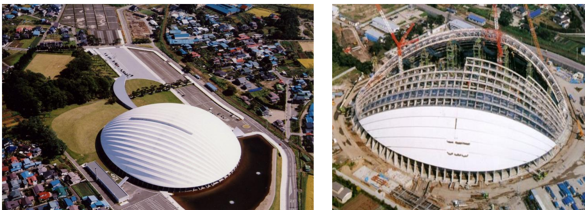
Slika 116: Pogled iz zraka na dvorano Odate Jukai Dome in dvorana med gradnjo[84].
