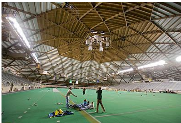
Slika 115: Notranji pogled na leseno konstrukcijo kupole [81].
