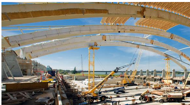
Slika 84: Gradnja ločnega lesenega ostrešja [54].
