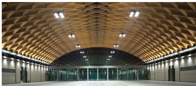
Slika 104: Lesen rešetkast obok z jeklenimi nateznimi vezmi [70].
