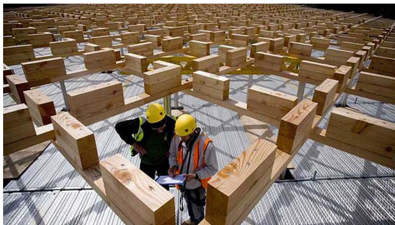
Slika 140: Strešna konstrukcija med gradnjo [65].
