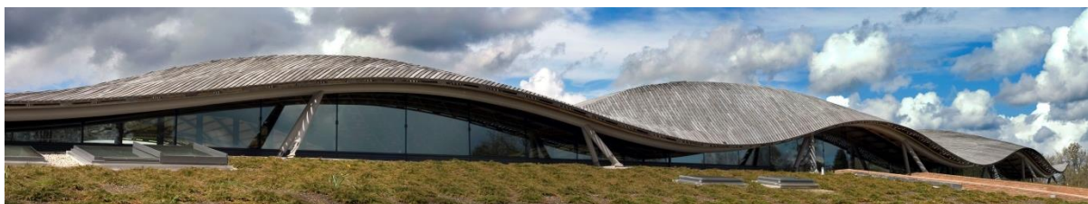
Slika 136: Savill Garden mrežna lupinasta konstrukcija [95].
