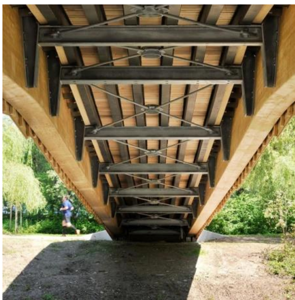
Slika 163: Prečne povezave obeh nosilcev in zavarovalna konstrukcija [115].
