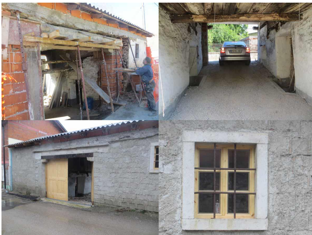
Slika 45: Prikaz izvedbe posega
