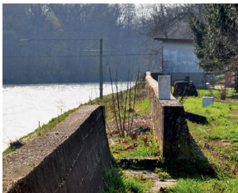
Slika 17: VP Gornja Radgona I in odprtina za dostop k strugi, ki se ob visokih vodah zatesni (foto: UL FGG, 2014).
