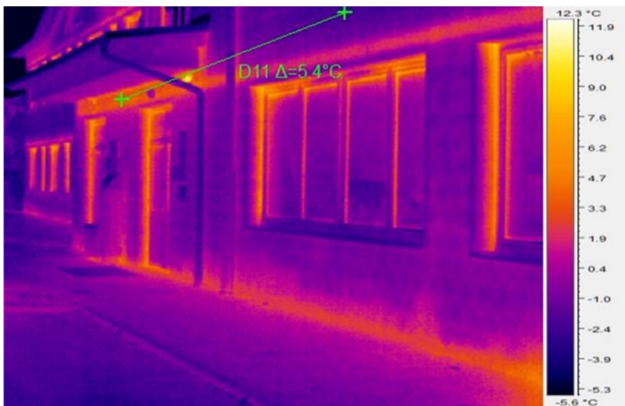
Slika 7: Termograf fasade severne strani (Vir: Lasten)
