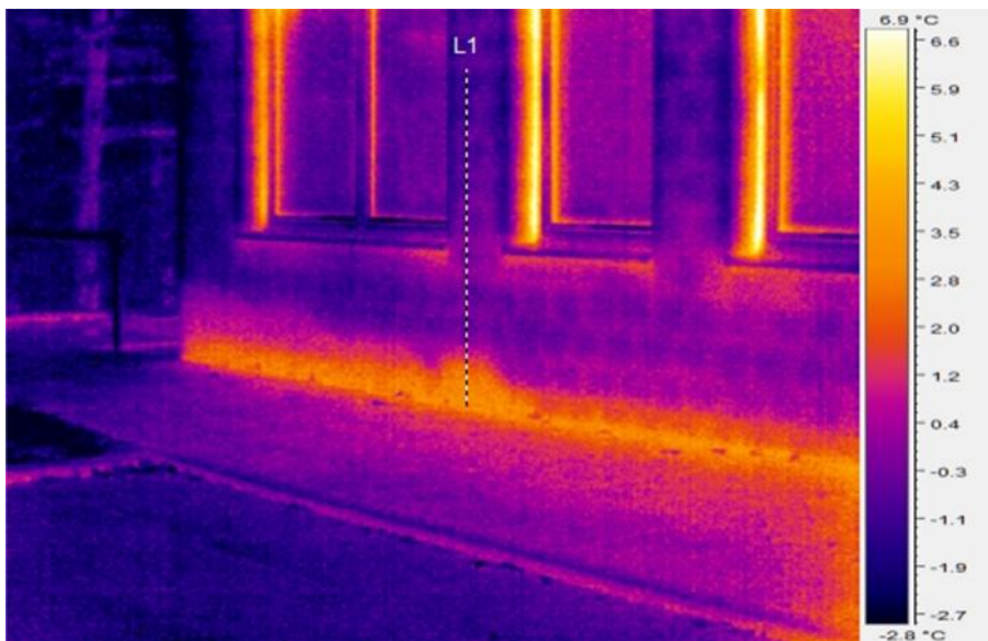
Slika 8: Termogram fasade severne strani (likovna u ilnica) (Vir: Lasten)
