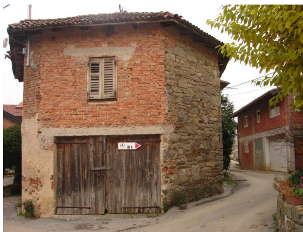
Slika 1.1: Obstoječe stanje obravnavanega objekta
