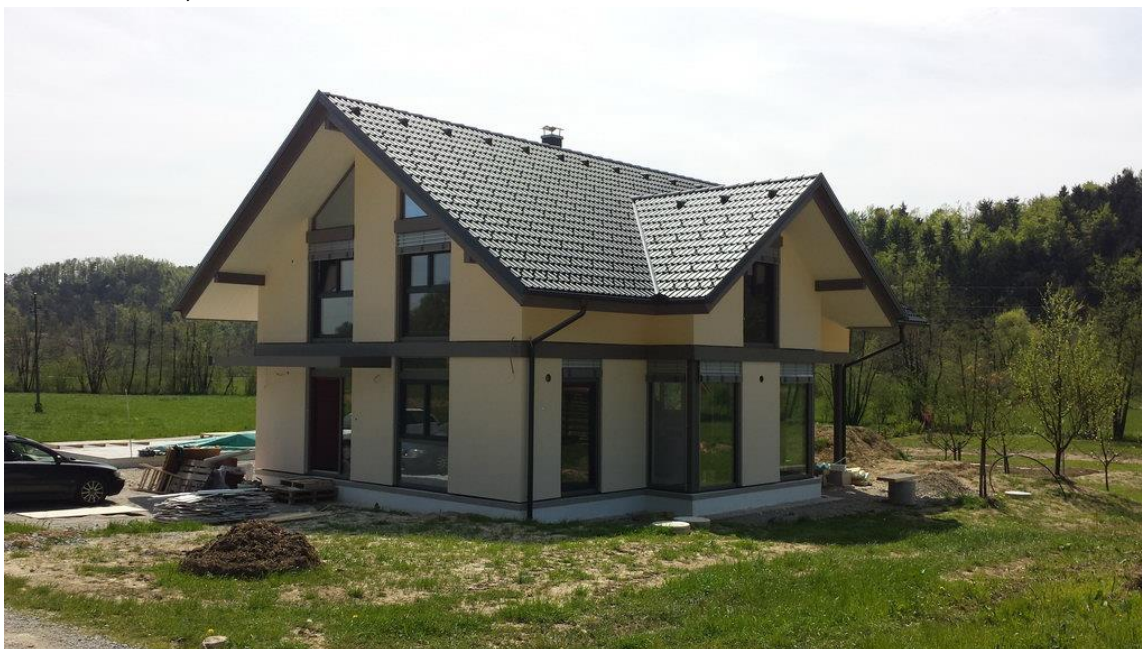
Slika 3 : Panelna konstrukcija (vir: www.kager.si )
