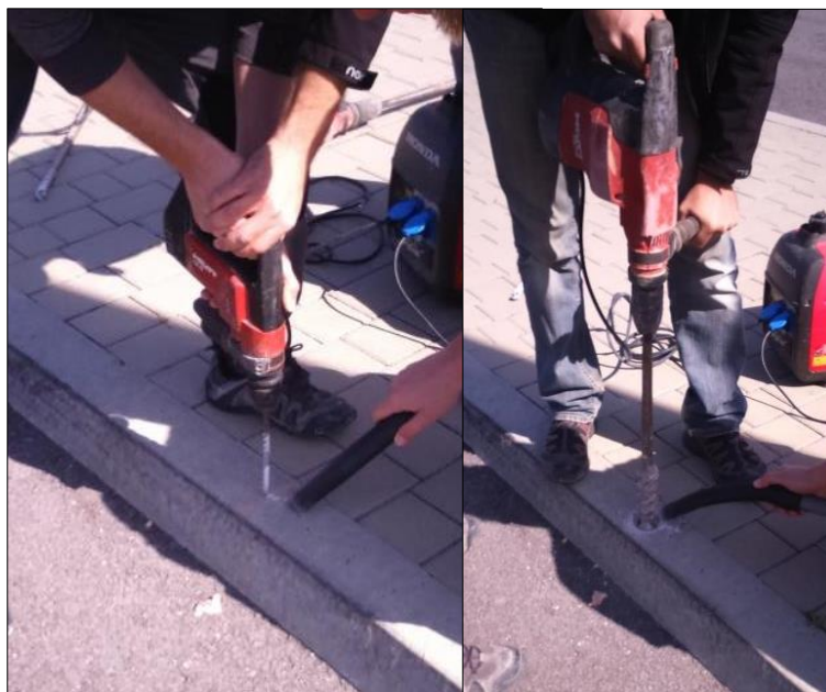
Slika 4: Vrtanje za stabilizacijo točk
