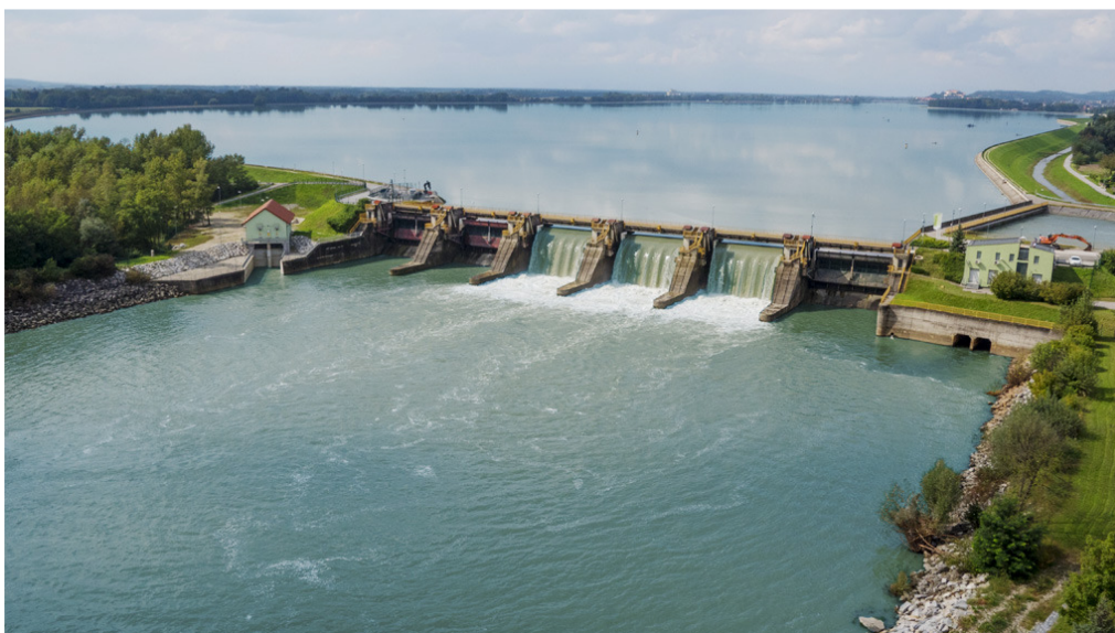
Slika 12: Jez Markovci in mala HE Markovci (Tehnično opazovanje objektov HE na Dravi za leto 2015-2016 URL, 2016) Figure 12: Dam Markovci and small hydroelectric power plant Markovci (Tehnično opazovanje objektov HE na Dravi za leto 2015-2016 URL, 2016)
