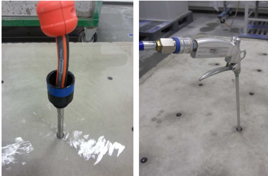
Slika 47: Izpiranje in izpihovanje diamantno izvrtanih izvrtin (lasten vir, 2015)
