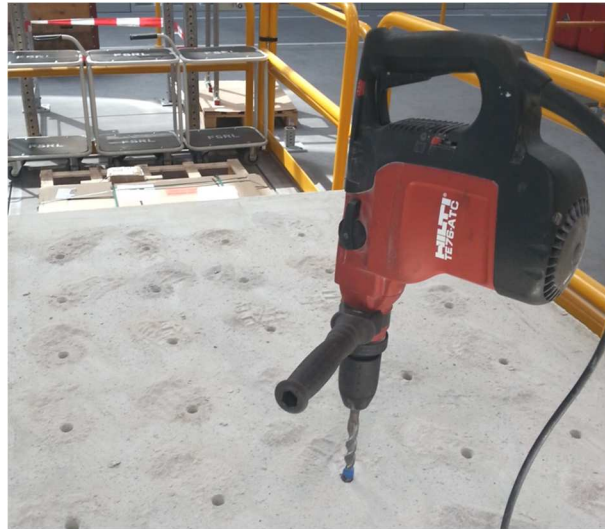
Slika 42: Vrtanje izvrtin z uporabo vrtnega kladiva Hilti TE76-ATC (lasten vir, 2015)
