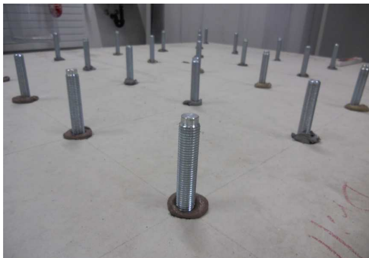
Slika 51: Sidrne palice M16 vgrajene v svežo sprijemno maso (lasten vir, 2015)
