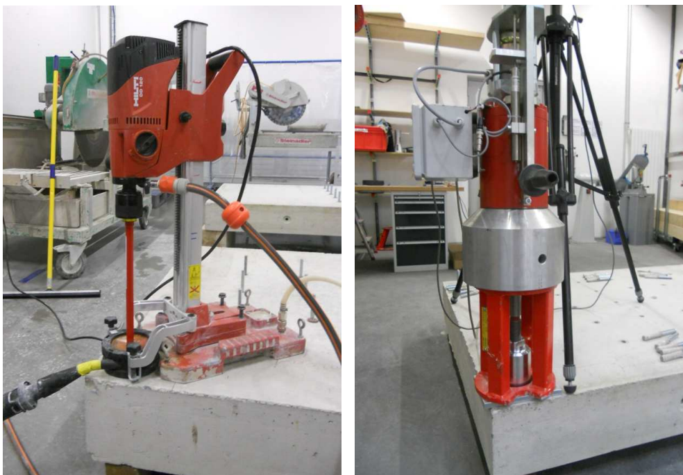
Slika 75: Vgradnja in izvedba izvlečnih preskusov na vogalu v betonu C20/25 (lasten vir, 2015)
