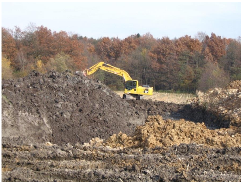
Slika 7: Prikaz izkopa gradbene jame za poznejše odlagališče gradbenih odpadkov
