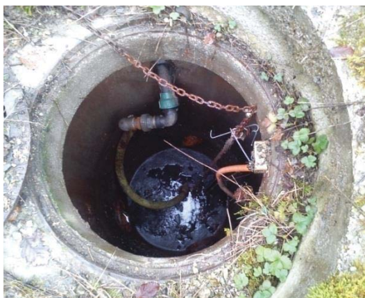
Slika 6: Kanalizacijsko črpališče
