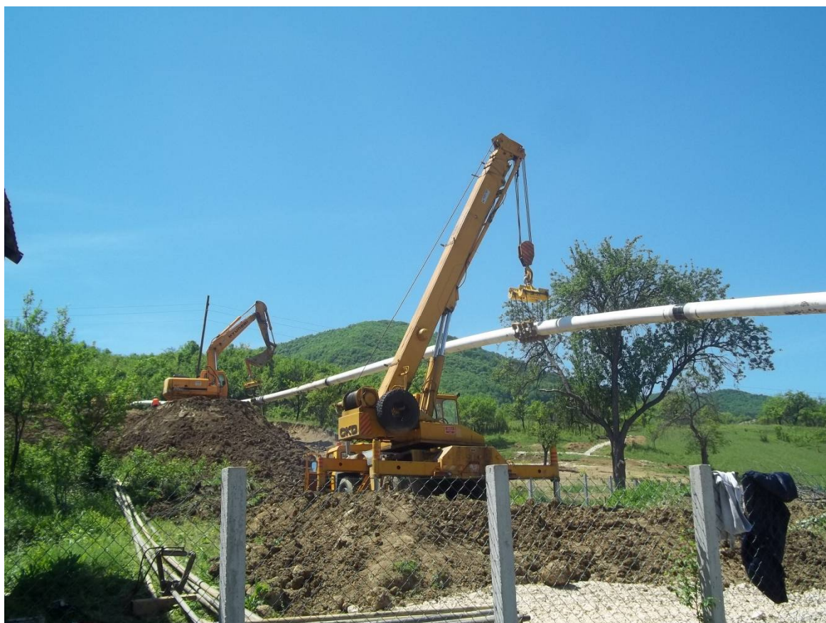
Slika 39: Montaža cevi s pomočjo dvigala (lasten arhiv)
