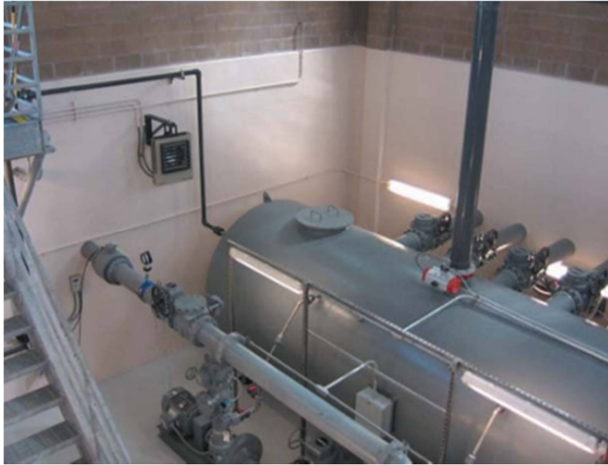
Slika 27: Prikaz vakuumskega kotla s pripadajočimi črpalkami ( http://www.airvac.com 16.05.2016)
