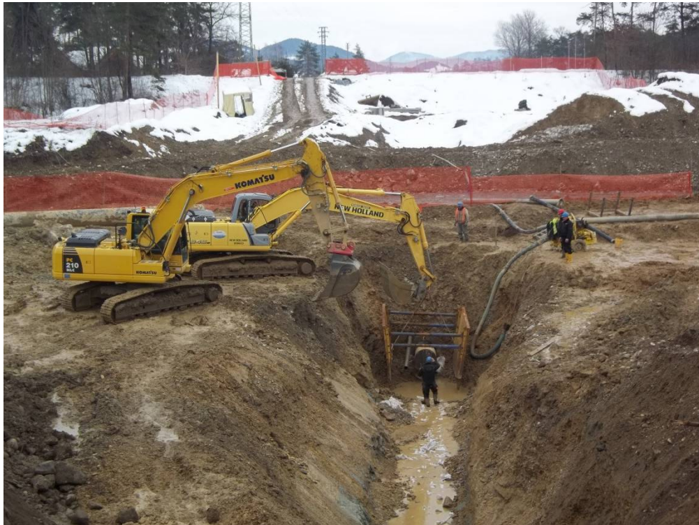
Slika 42: Primer prekopa večje reke, Savinje (lasten arhiv)
