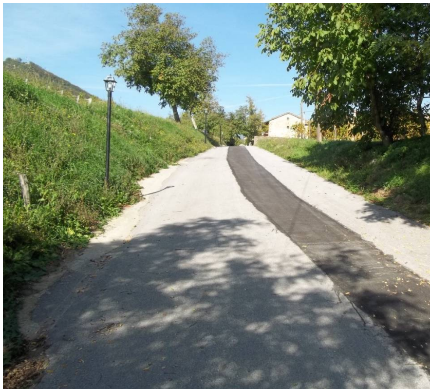
Slika 35: Cesta, pod katero je predviden cevovod v Slapah (lasten arhiv)
