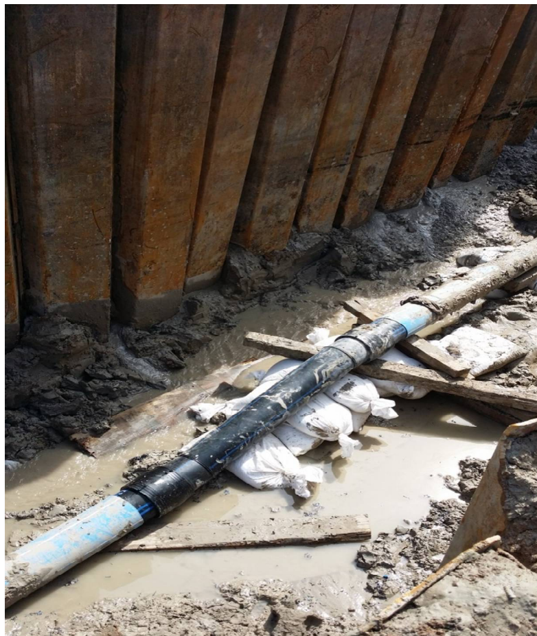
Slika 48: Primer polaganja žagastega profila pri vakuumski kanalizaciji (lasten arhiv)
