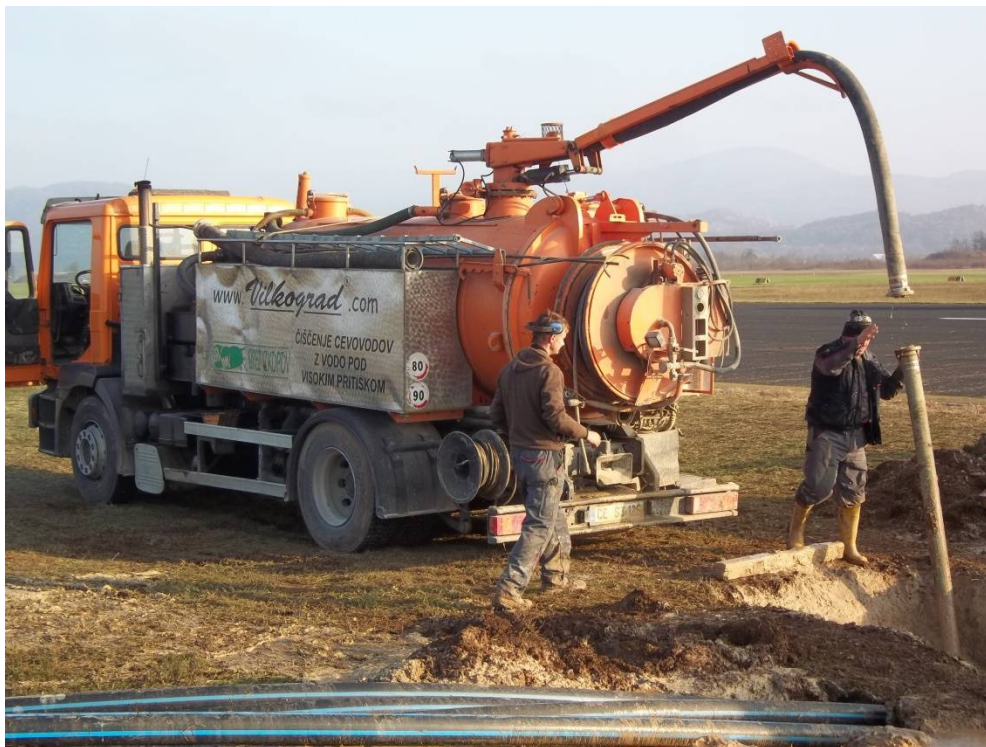
Slika 36: Črpanje bentonitnih odplak (lasten arhiv)
