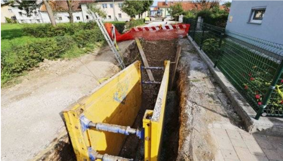
Slika 11: Prikaz razpiranja jarka (lasten arhiv)
