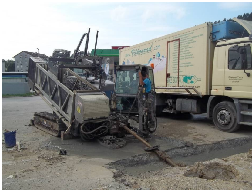
Slika 45: Prečkanje reke Save v Litiji – vrtnalna garnitura (lasten arhiv)
