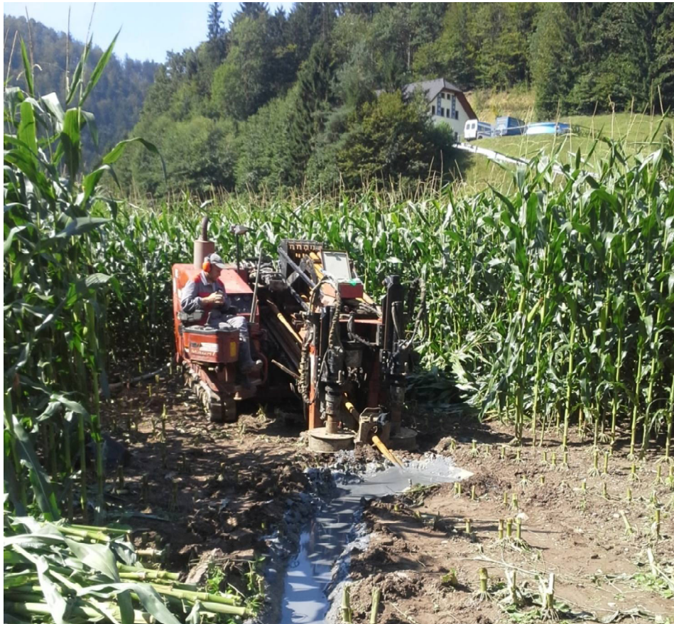
Slika 2: Izdelava pilotne vrtine (www.vilkograd.com, pridobljeno 12.04.2016)
