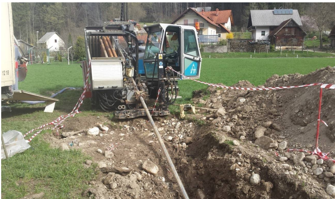
Slika 50: Prikaz vrtalnega stroja med izvedbo pilotne vrtine (lasten arhiv)
