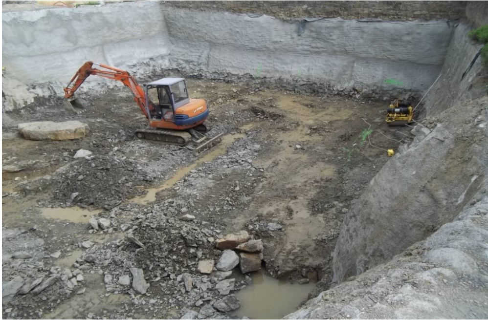
Slika 33: Gradbena jama v Slapah pri Vipavi (lasten arhiv)
