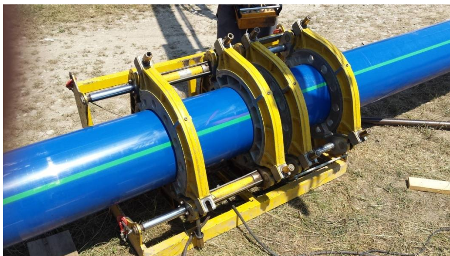
Slika 46: Prikaz sočelnega varjenja PEHD cevi (lasten arhiv)
