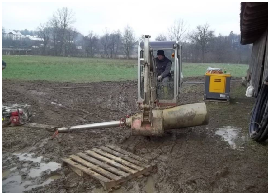
Slika 38: Nameščanje razširjevalca na vrtalne palice (lasten arhiv)
