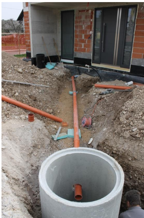
Slika 5: hišni priključek kanalizacije (vir: Lasten)
