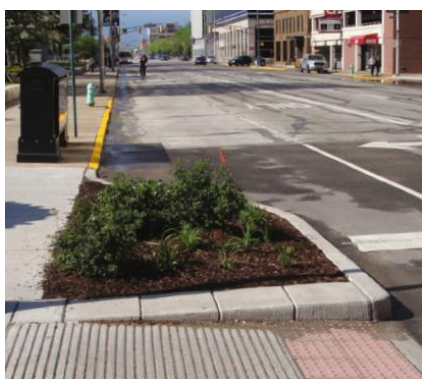
Slika 63 : Razširitev pločnika v parkirni pas Razširitve pločnika zmanjšajo širino ceste in s tem vizualno
