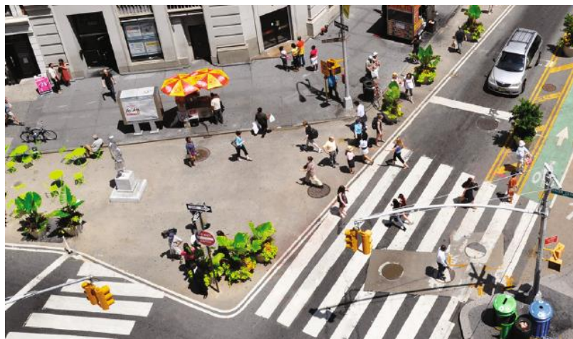
Slika 28 : Rekonstrukcija kompleksnega križišča v New Yorku
