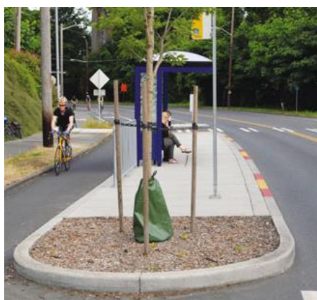
Slika 77: Kanalizirana kolesarska steza za avtobusnim postajališčem (USDG,2013)
