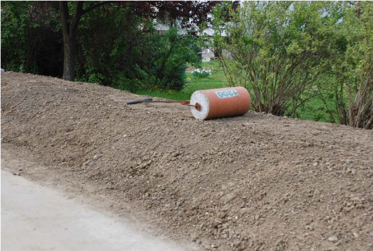
Slika 8: Gradnja protipoplavnega nasipa v Celju (Sedempet, 2016)
