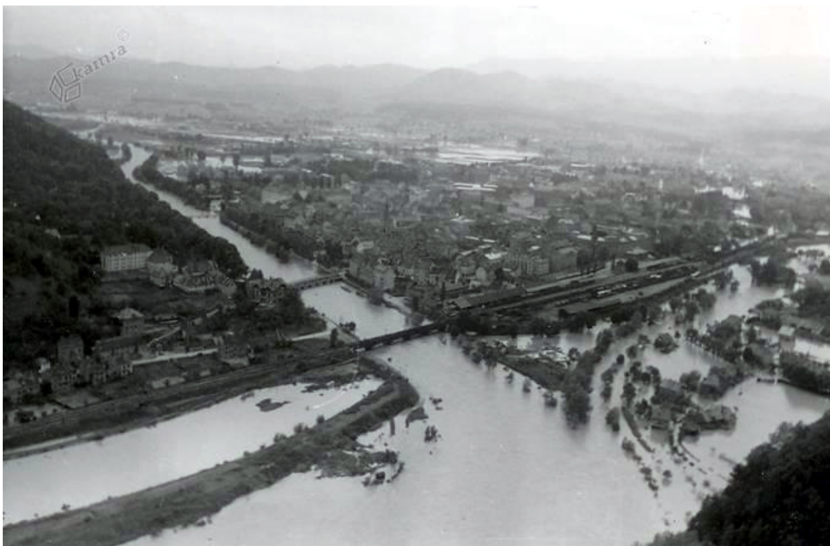
Slika 7: Poplavljenno Celje 1954, spredaj sotočje Savinje in Voglajne (Kamra, 2016b)
