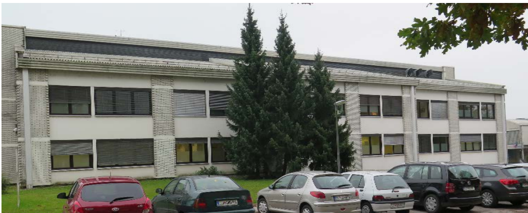
Slika 6: Pogled na zahodno fasado
