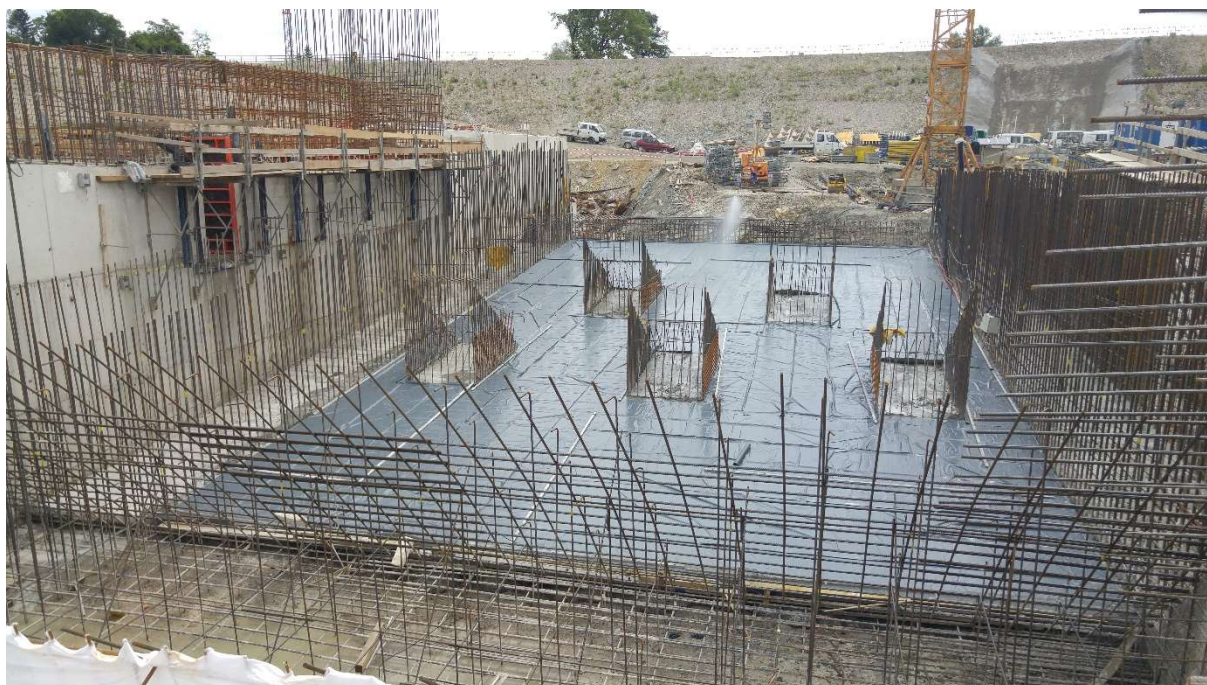
Slika 24: Zaščita betona z zaščitno folijo po betoniranju na HE Brežice (vir: lasten)
