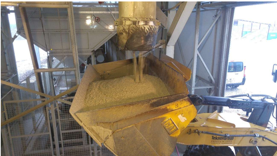
Slika 30: Sveža betonska mešanica (vir: lasten)
