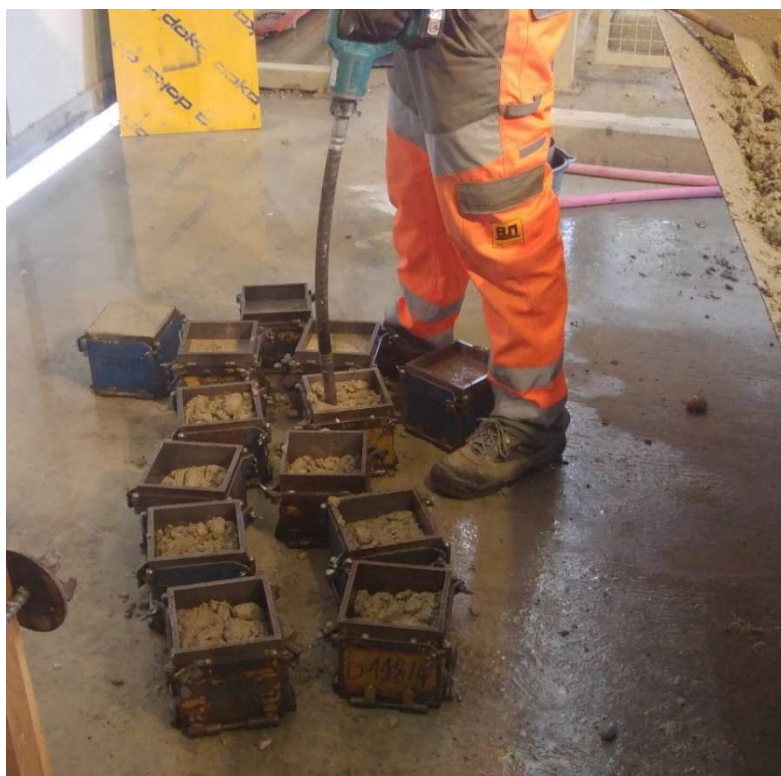
Slika 39: Odvzem vzorcev za določitev trdnostnih karakteristik betona
