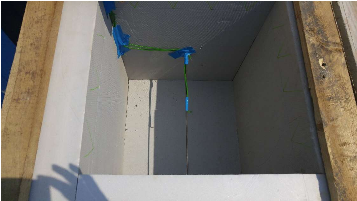
Slika 29: Termočleni v kalupu pred betoniranjem (vir: lasten)
