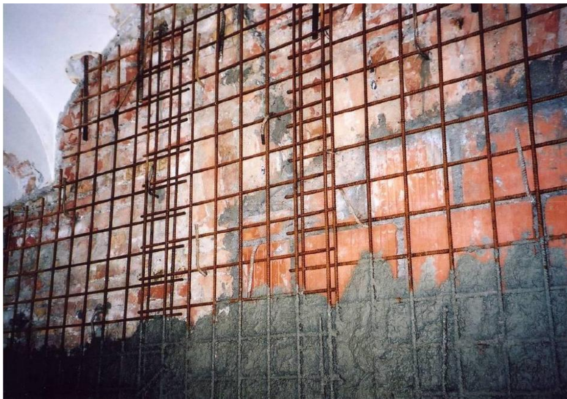
Slika 16: Primer izvedbe notranje ojačitve zunanjih nosilnih zidov. Vir: utrditev zidanih konstrukcij, Marko Keše Inpro, d. o. o.
