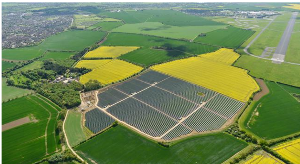
Slika 9: Solarni park velikosti 12MWp v Angliji (Solarni park, 2016)
