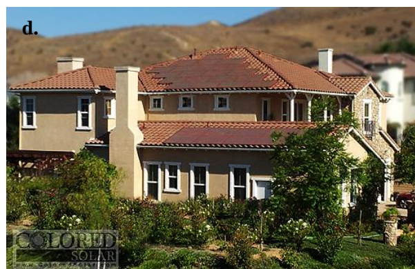
Slika 18: Barvni moduli na objektu
