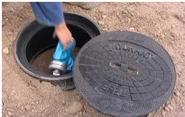
Slika 32: Na vodovodni sistem vgrajen teleskopski hidrant s cestno kapo (Hawle, 2016)
