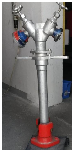
Slika 30: Hidrantni nastavek je po obliki in uporabnosti podoben nadtalnemu hidrantu – ima priklon za gasilsko cev in ventil za določanje pretoka požarne vode (lasten vir, 2015)
