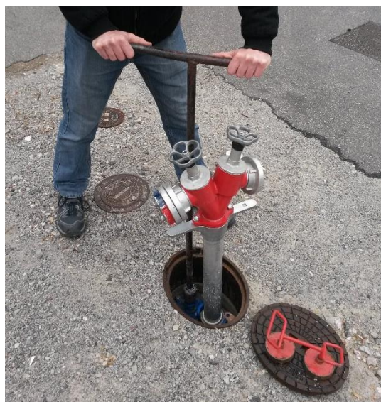
Slika 52: Po vizualnem pregledu se namestita hidranti nastavek in hidranti ključ
