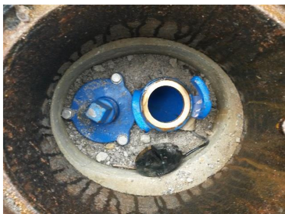
Slika 51: Pri pregledu hidranta se najprej opravi vizualni pregled hidranta - ustje hidranta in glava nastavka za hidranti ključ
