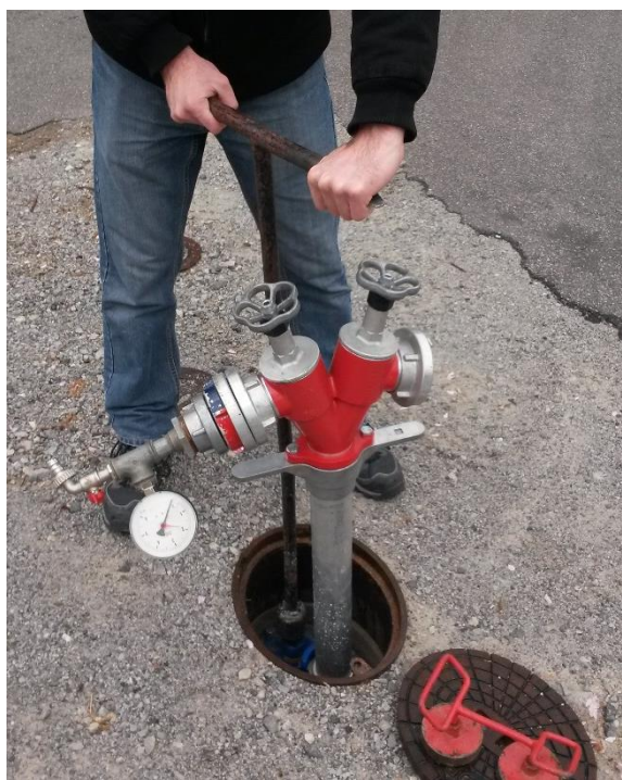
Slika 53: Na izliv hidrantnega nastavka se nastavi ročnik z manometrom in odpre zasun hidranta s pomočjo hidrantnega ključa
