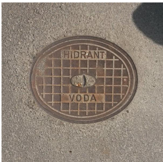
Slika 29: Podzemni hidrant je težje opazen, saj je vidna le cestna kapa (lasten vir, 2015)
