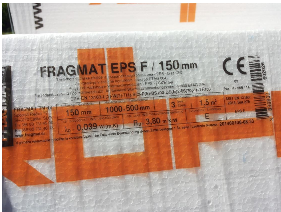
Slika 15: Kontrola dobavljenega materiala, ki je bil vgrajen
