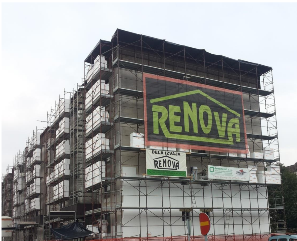
Slika 13: Zavarovanje gradbišča, postavitve zaščitnega in gradbenega odra in pričetek sanacije
