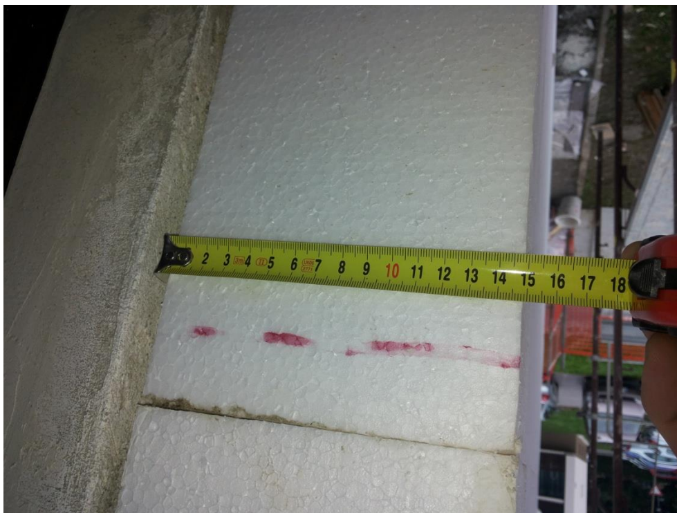
Slika 16: Kontrola debeline vgrajenega materiala (za izpolnitev pogojev EKO sklada)
