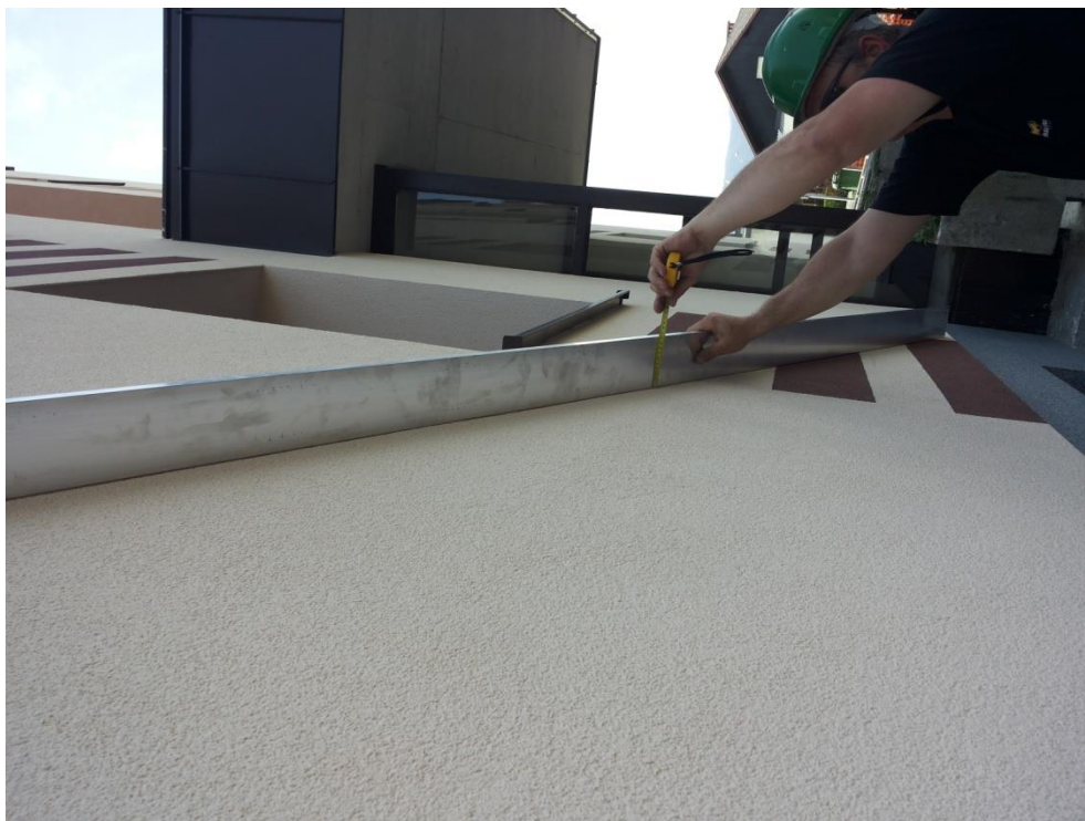
Slika 18: Meritve ravnosti izvedenih del
