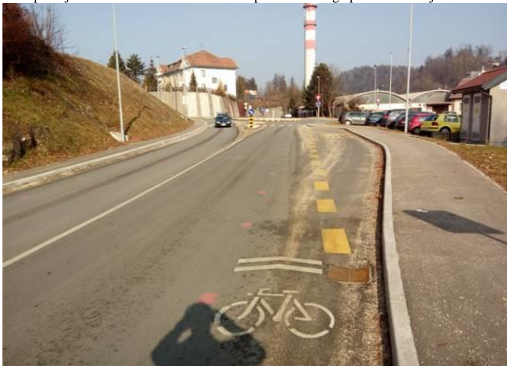
Slika 32: Začetek odseka 1 0,100 km v smeri stacionže. Horizontalna signalizacija (Sharrows), ki upozarja voznike motornih vozil na souporabo voznega pasu s kolesarji.
