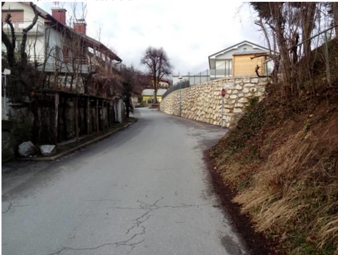
Slika 35: 0,800 km v smeri stacionaže.
