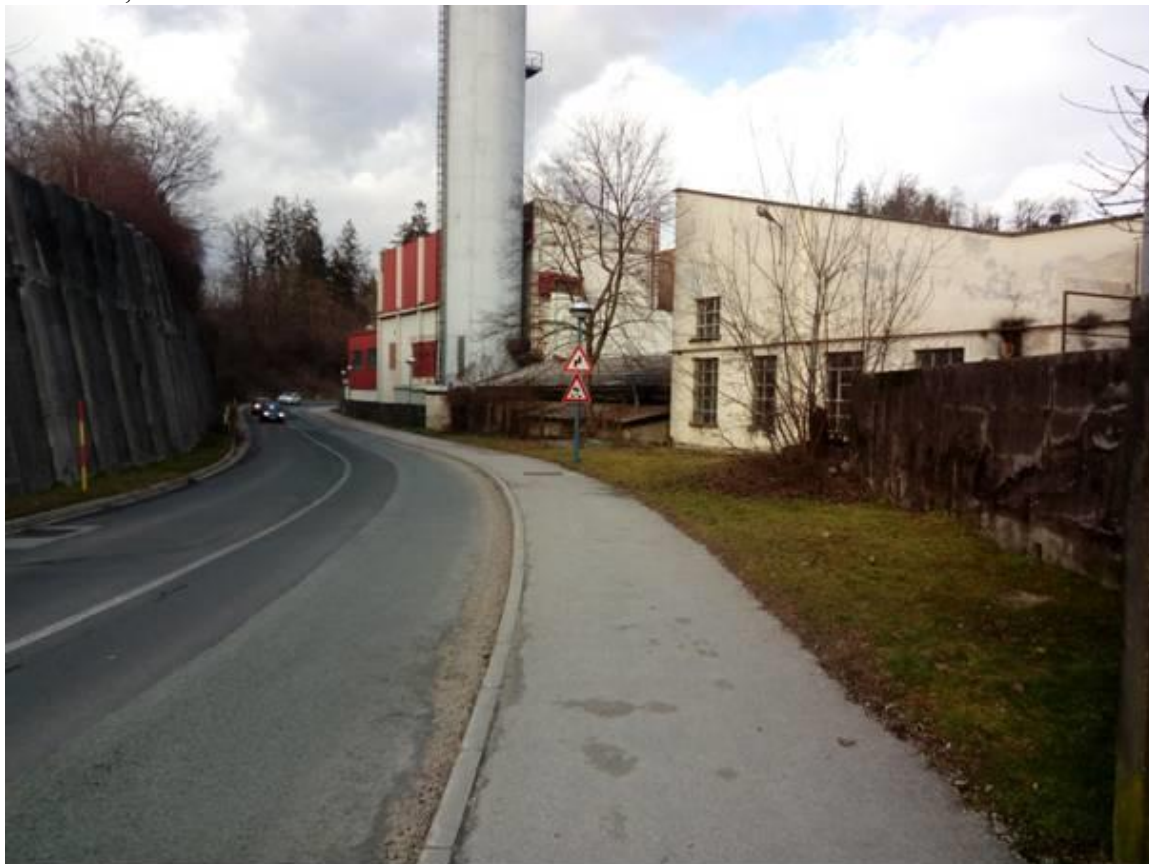
Slika 33: 0,250 km v smeri stacionaže.
