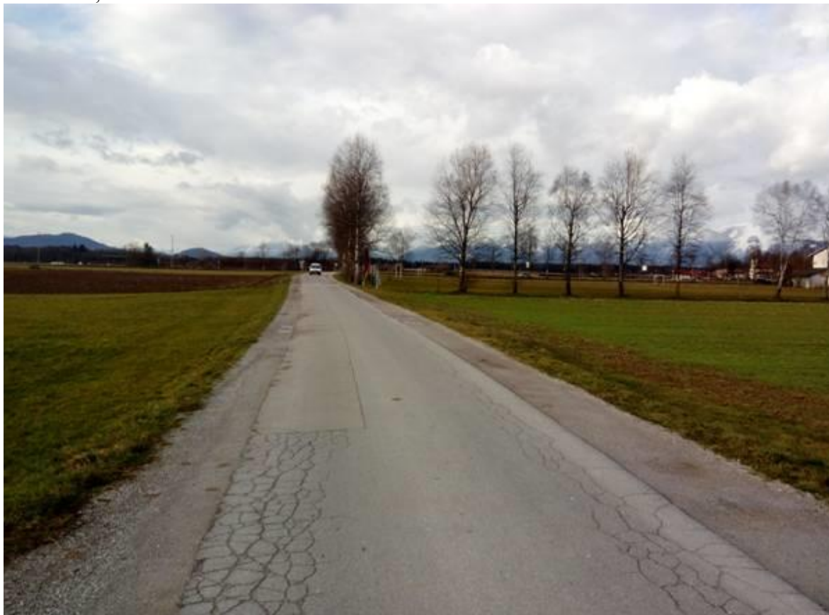
Slika 46: 4,200 km v smeri stacionaže.
