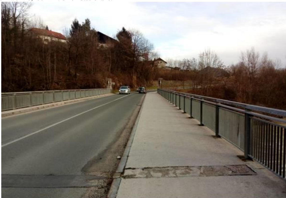
Slika 34: 0,400 km v smeri stacionaže.
