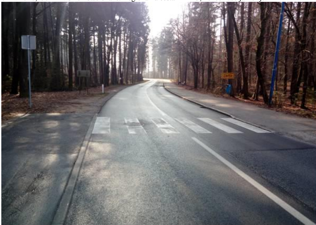
Slika 48: 6,450 km v smeri stacionaže. Regionalna cesta R2 413, konec naselja Zbilje.
