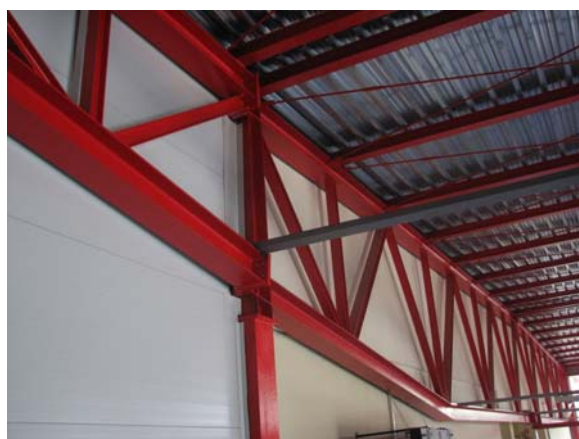
Palični nosilec glavnega okvira v prečni smeri
