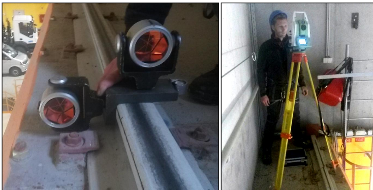
Slika 23: Levo: signalizacija tirnice s platformo L; desno: stojišče instrumenta
