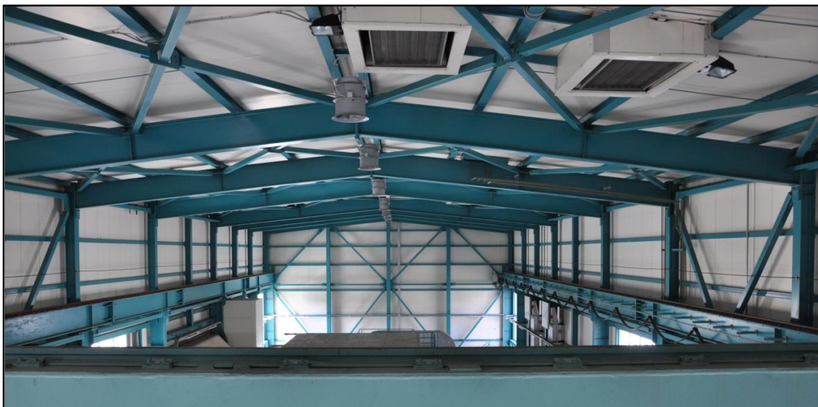
Slika 28: Tirnici žerjavne proge na južni in severni strani strojnice
