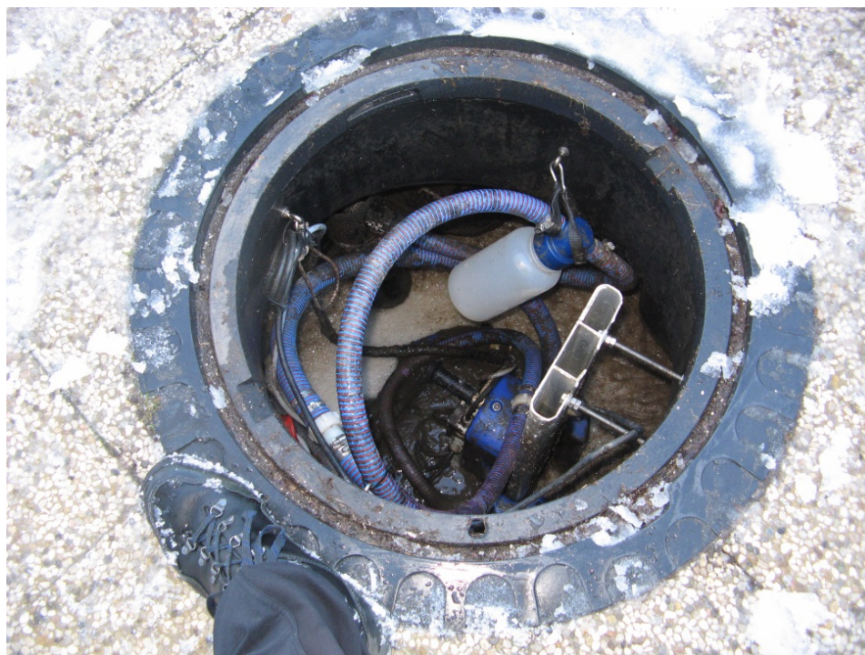
Slika 3: Merilno mesto iztok na MKČN na Lubniku.
