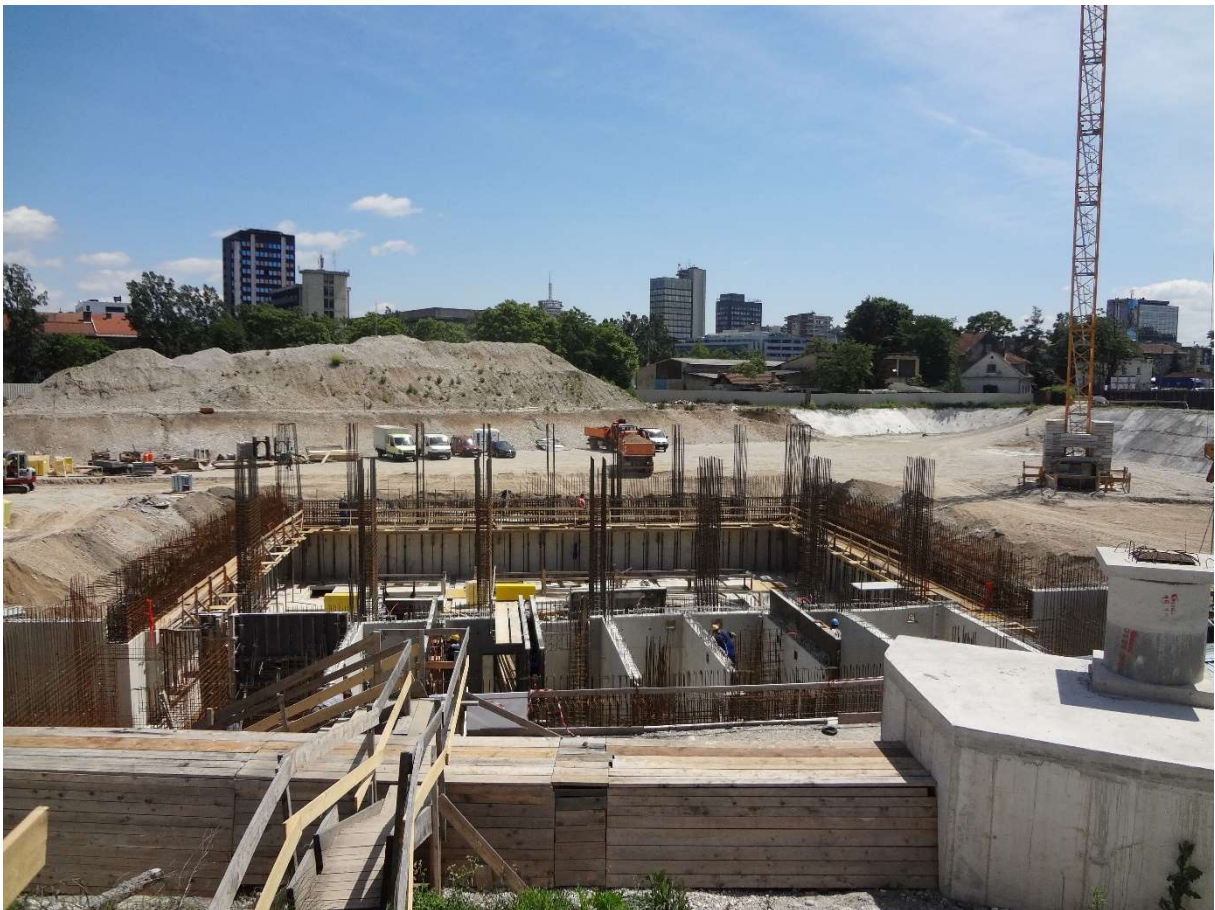
Slika 14: Gradbišče Džamije v Ljubljani.
