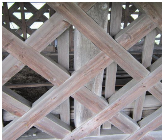
Slika 7: Steber (S2) v vzdolžni brani.
