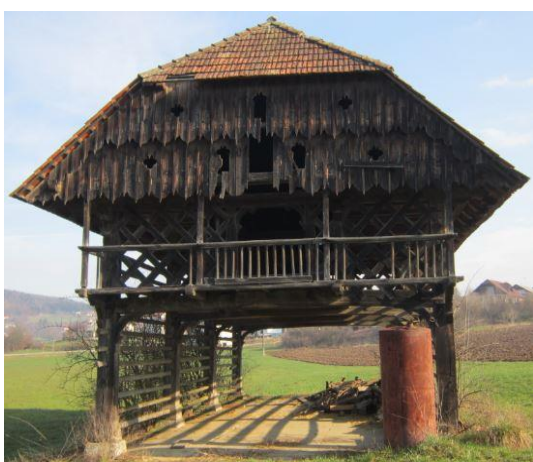
Slika 2: Objekt od spredaj.
