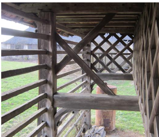
Slika 4: Pogled po trupu konstrukcije.
