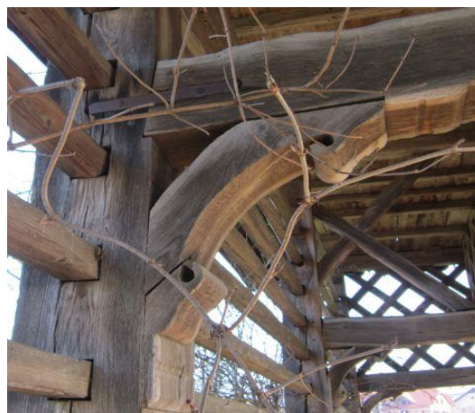
Slika 5: Stik stebra in glavne grede.
