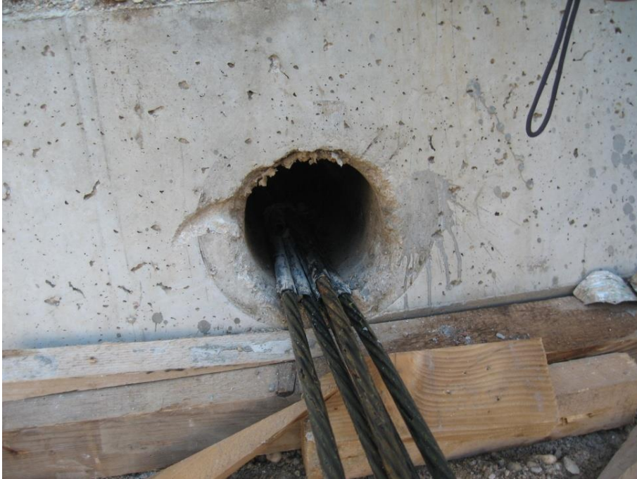
Slika 50: Odrezana injekcijska cev in odstranjen zaščitni ovoj. (Vir: lastna fotografija)
