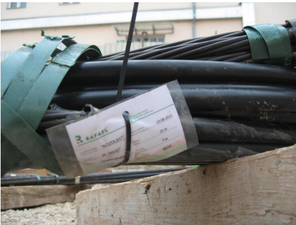
Slika 29: Podatki o TS ter razlika med veznim in prostim delom sidra (Vir: lastna fotografija)
