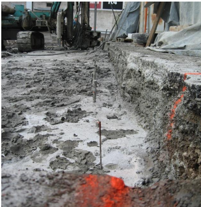
Slika 19: Pogled vzdolž osi A od Knjižnice Otona Župančiča proti 1. fazi PGH (Vir: lastna fotografija)
