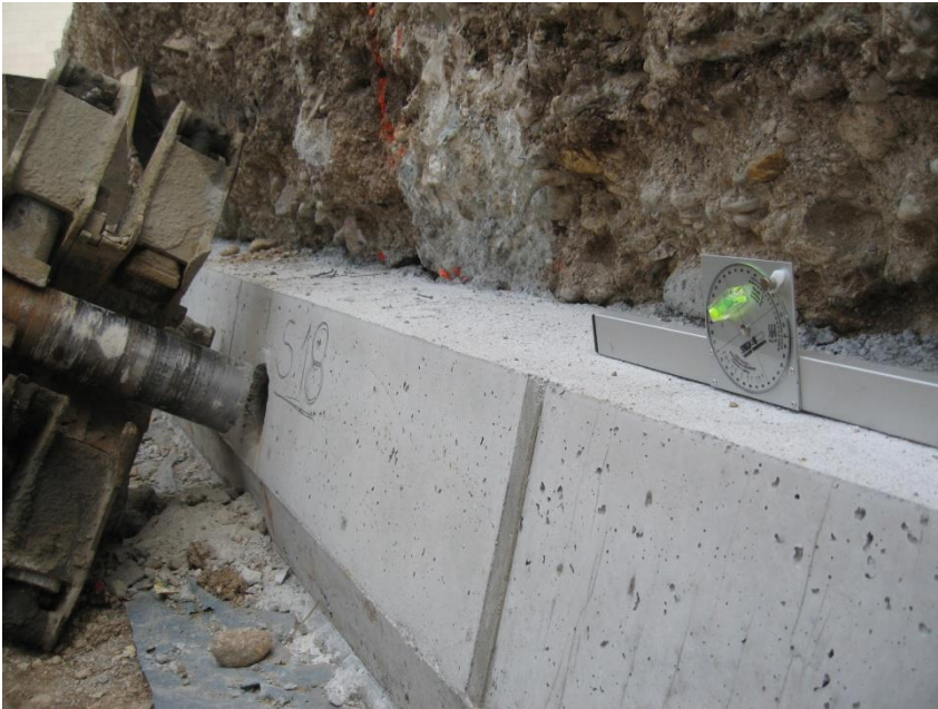
Slika 44: Razlika v naklonih med vrtnim drogovjem in naklonom naležne površine na gredi (Vir: lastna fotografija)
