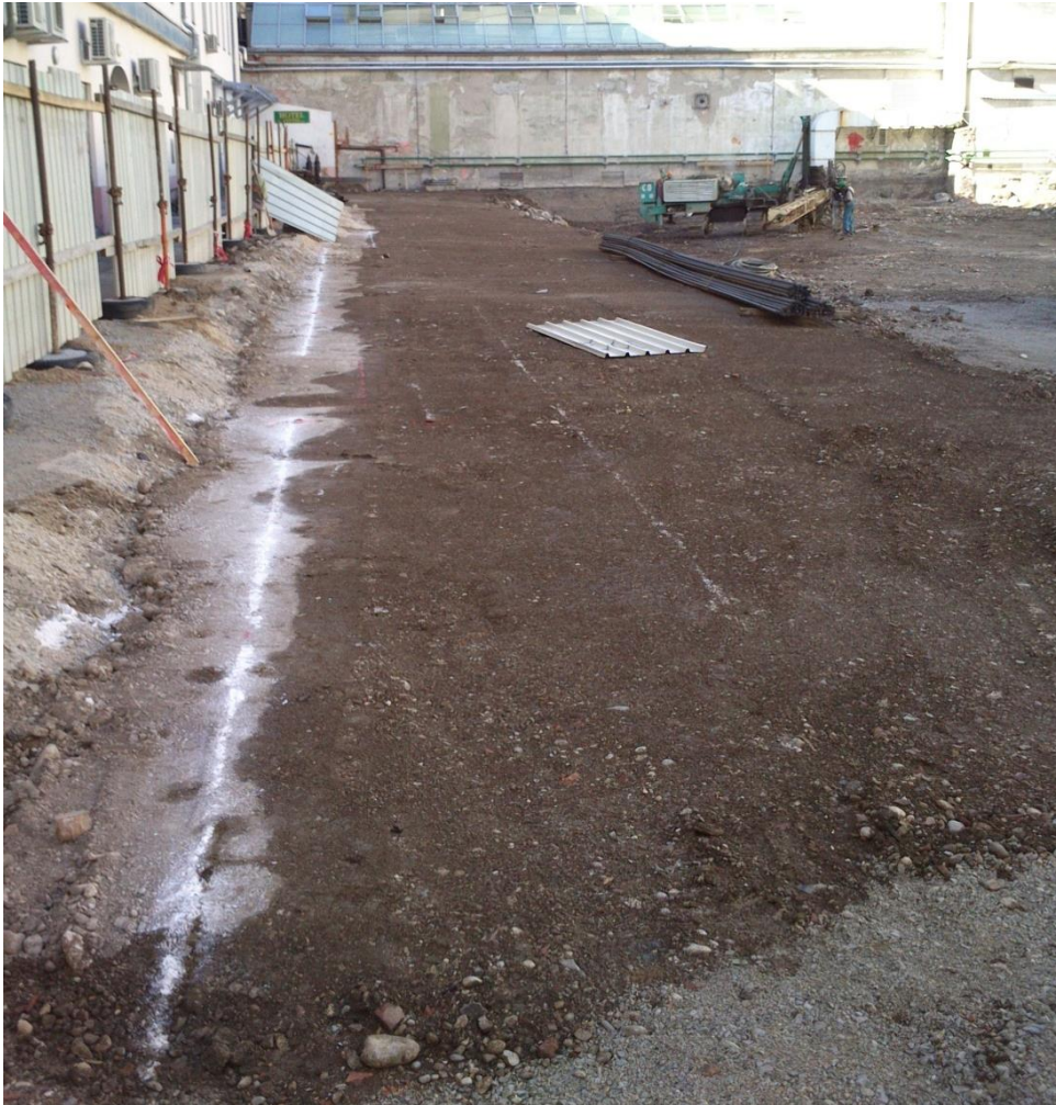
Slika 17: Označba linije in pozicij jet slopov vzdolž osi F (tudi stanje po neurju prejšnji dan) (Vir: lastna fotografija)
