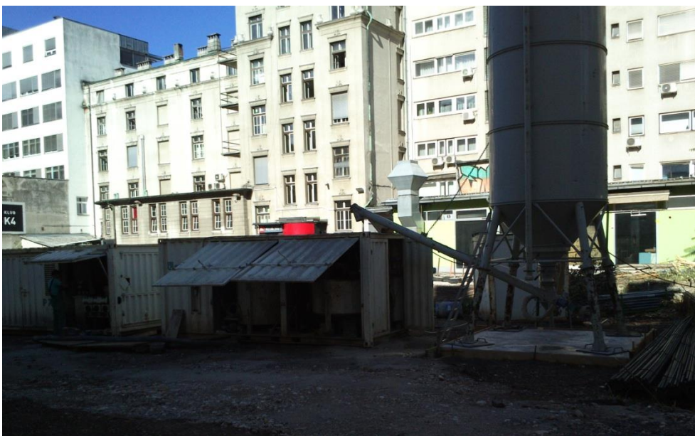
Slika 8: Pogled na gradbišče (Vir: lastna fotografija)
