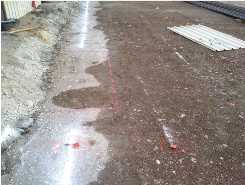
Slika 25: Razdalje med vročevodno kineto, osjo varovalne stene s pozicijami jet slopov ter pozicijo bodoče garažne hiše (Vir: lastna fotografija)
