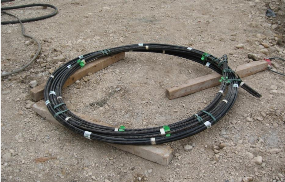
Slika 28: Testno sidro čaka na vgradnjo. (Vir: lastni fotografiji)
