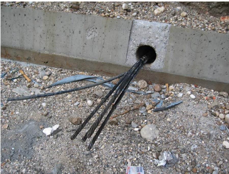
Slika 49: Zainjektirano sidro v fazi pred napenjanjem. (Vir: lastna fotografija)
