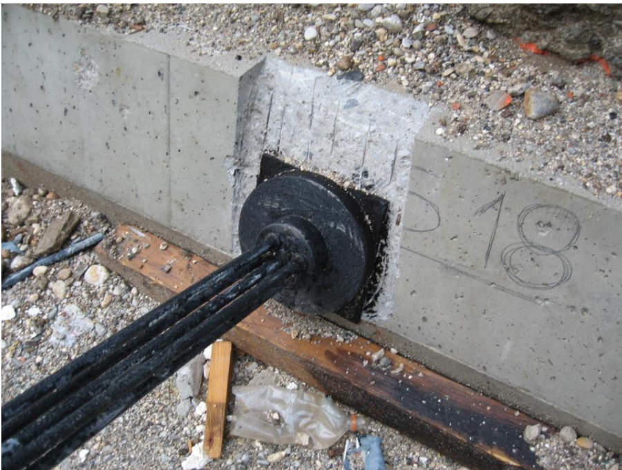
Slika 45: Sanacija naklona ležišč grede v območju glave sider (Vir: lastna fotografija)
