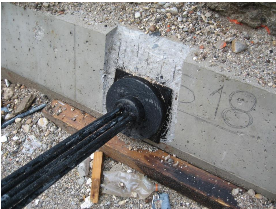
Slika 51: Napeto, zaklinjeno in zaščiteno sidro, ki že opravlja svojo funkcijo. (Vir: lastna fotografija)
