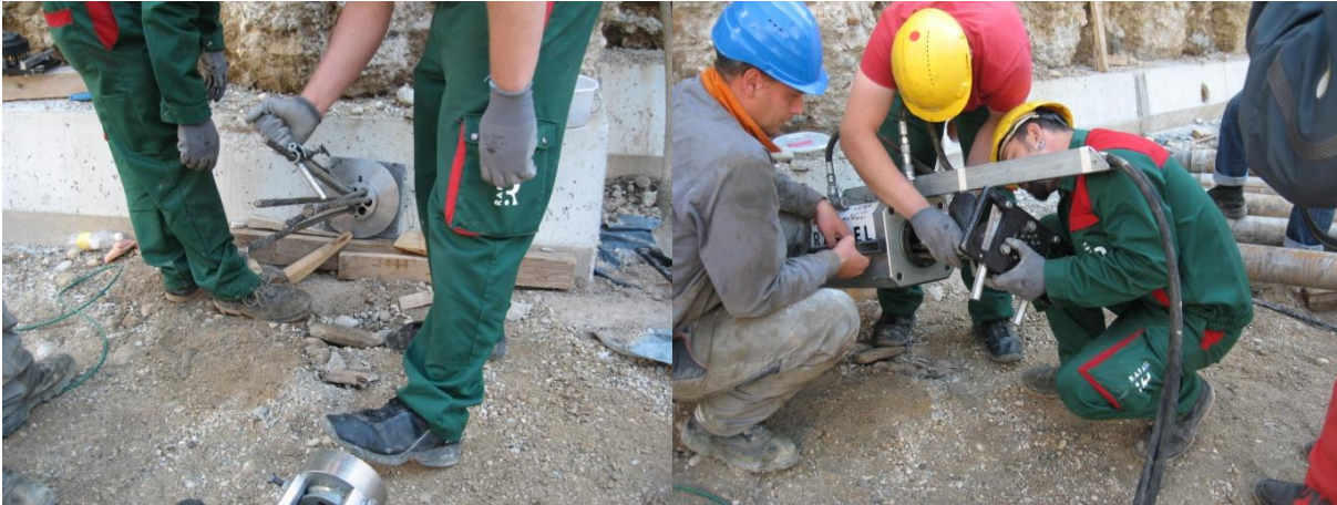
Sliki 47 in 48: Levo nameščanje zakovic, desno nameščanje napenjalke za zaklinjanje pri V_0 . (Vir: lastni fotografiji)
