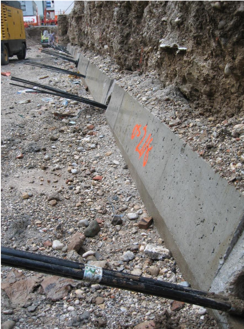
Slika 46: Vzdolžni pogled na zgornjo sidrno gredo ob objektu Hotel Center (Vir: lastna fotografija)
