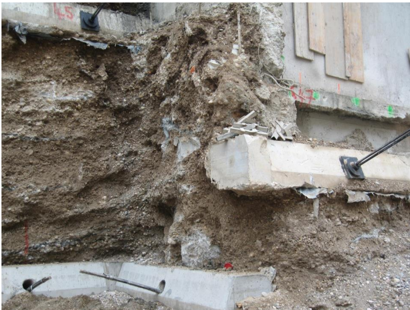
Slika 43: Situacija sidra po injektiranju (Vir: lastna fotografija)
