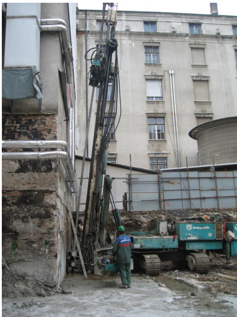
Slika 27: Prikaz inštalacije, zaradi katere smo povečali naklon injektiranja pri knjižnici (Vir: lastna fotografija)
