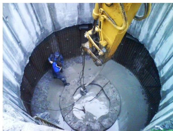
Slika 38: Priprave na betoniranje sekundarne AB obloge (Foto: Metod Krajnc)
