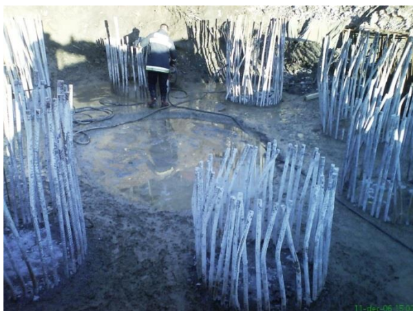
Slika 35: Izvedba primarne obloge – piloti fi 150 cm (Foto: Metod Krajnc)
