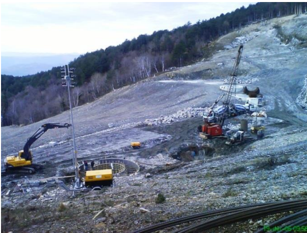
Slika 41: Pogled na gradbišče – v ozadju končani AB vodnjaki, v ospredju v izdelavi (Foto: Metod Krajnc, ISB d.o.o.)
