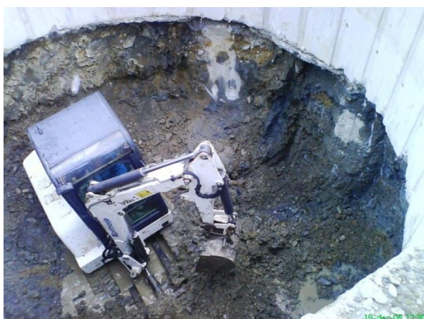
Slika 37: Izkop zemljine za izgradnjo naslednjega odseka sekundarne AB obloge (Foto: Metod Krajnc)
