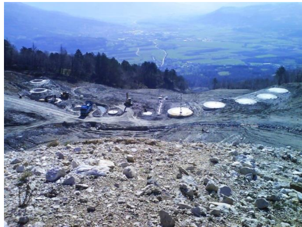
Slika 42: Pogled na gradbišče in dolino (Foto: Metod Krajnc, ISB d.o.o.)
