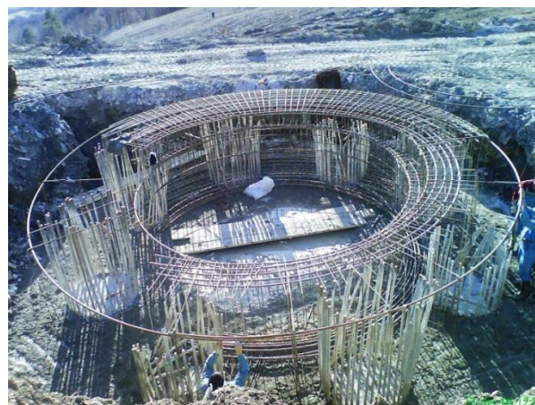
Slika 36: Polaganje armature za AB vezno gredo (Foto: Metod Krajnc)
