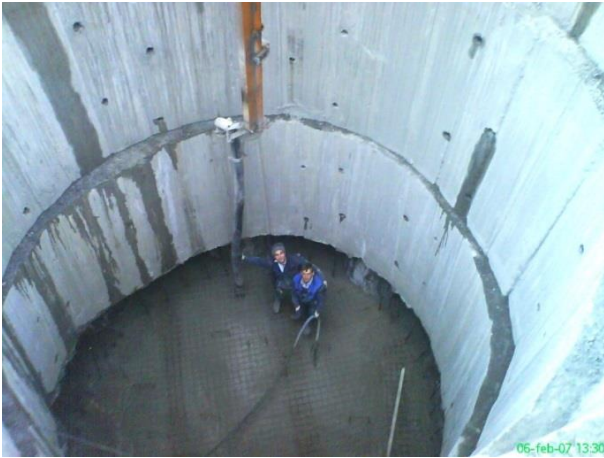
Slika 39: Priprava na betoniranje temeljne plošče (Foto: Metod Krajnc)
