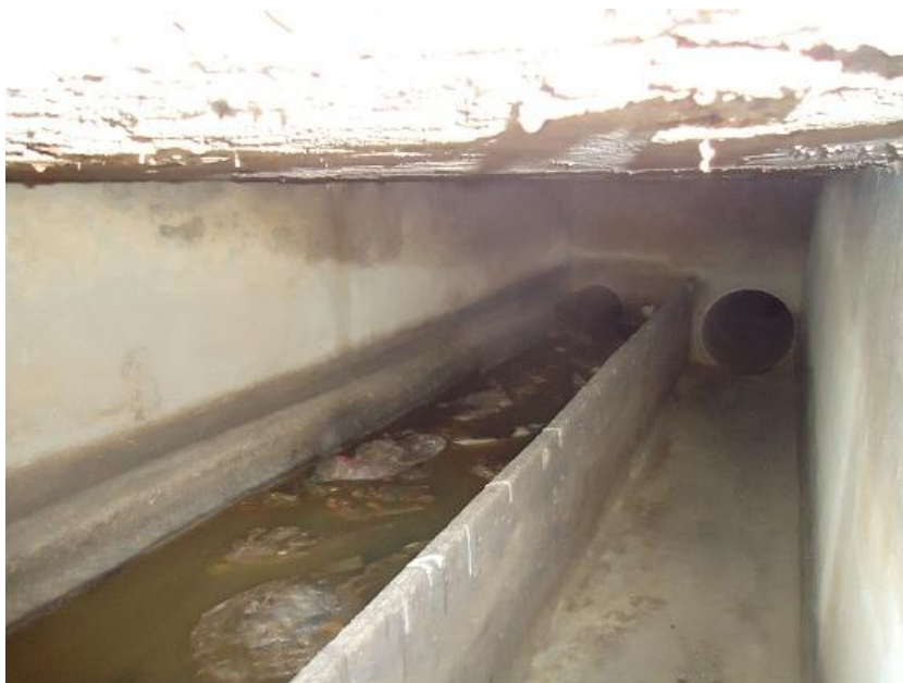
Slika 22: Razbremenilni objekt pri sušnem pretoku (slikano 6. 11. 2015)
