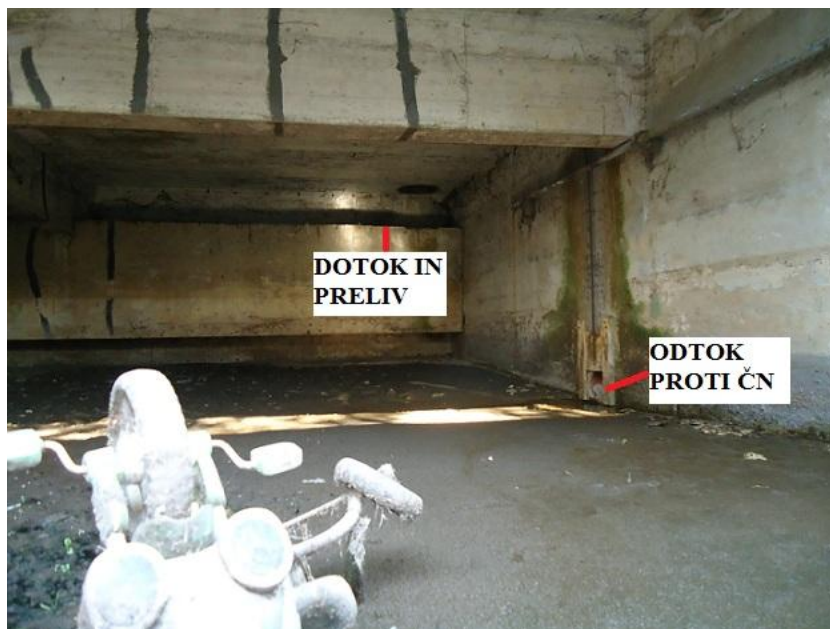
Slika 24: Zadrževalni bazen (slikano 6. 11. 2015)
