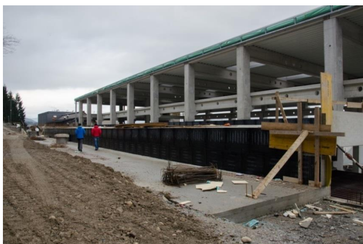
Slika 2: Zgornja stran opornega zidu, kjer so predvidena gradbena dela.
