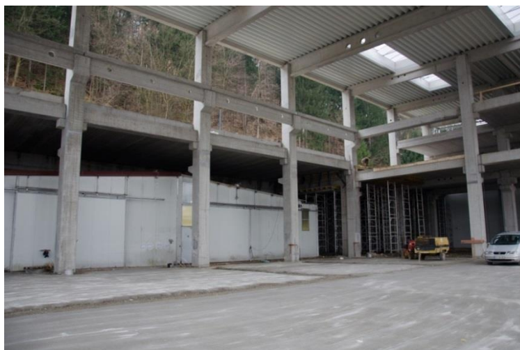
Slika 1: Oporni zid znotraj proizvodne hale.
