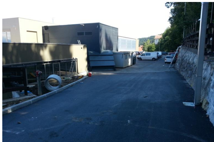
Slika 4: Zgornja stran opornega zidu po izvedenih ureditvenih delih.
