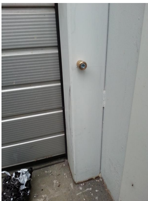
Slika 15: Vgrajen kontrolni reper.
