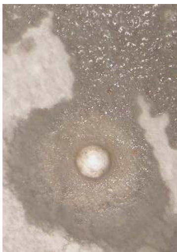
Slika 18: Talni reper MA01 na vhodu v objekt (tudi gravimetrična točka)
