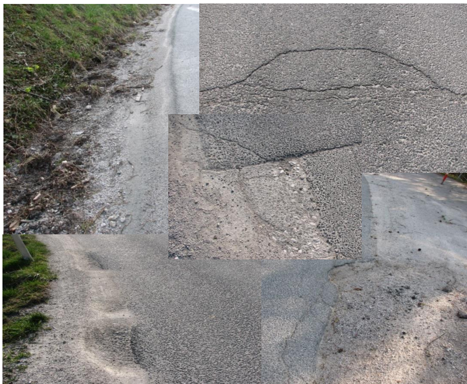
Slika 8: Primeri dotrajanega asfalta
