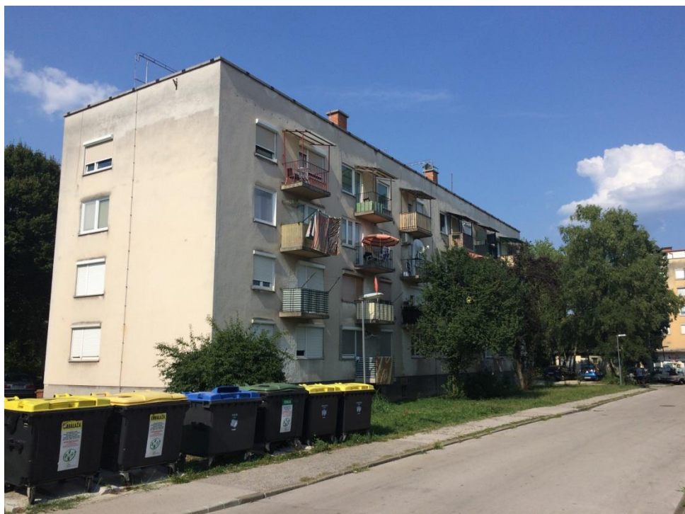
Slika 1: Obravnavani večstanovanjski objekt (Vir: lasten, 2015)
