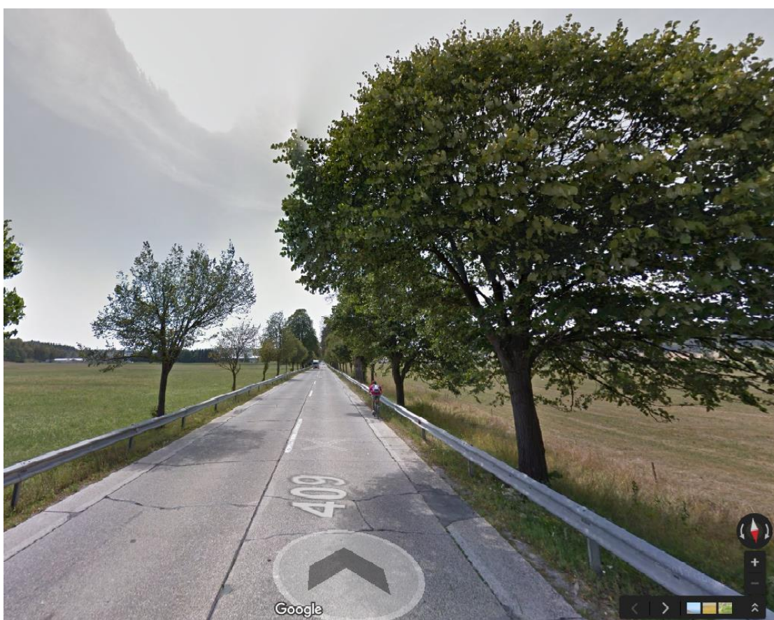
Slika 5-16: Drevored Napoleonove lipe, kjer je celotna vozna površina betonska. Kolesarji zametek razširjenega robnega pasu že uporabljajo (Google maps, 2013).
