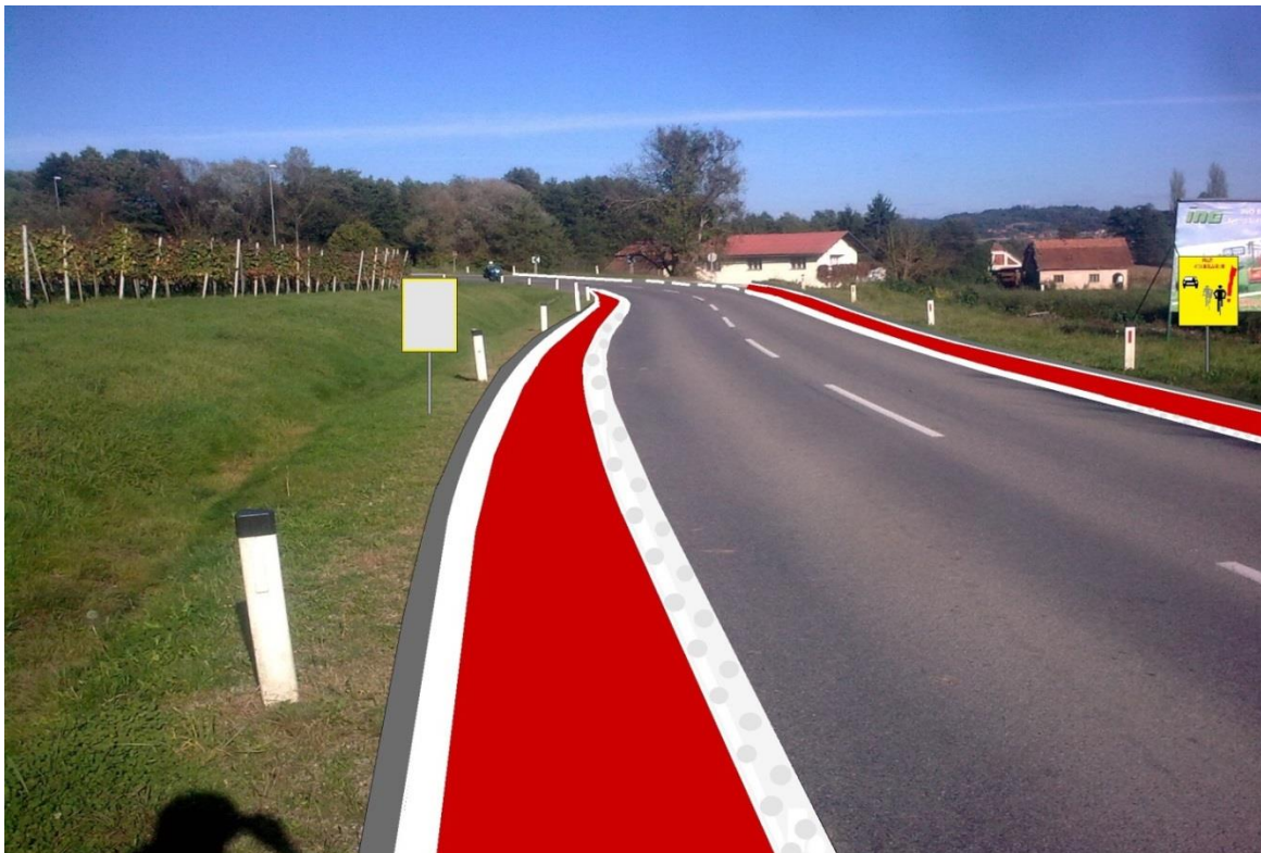
Slika 5-8: Najdražja izvedba razširjenega robnega pasu na odseku, prikazanem na sliki 55, ko je pas v celoti rdeče pobarvan.
