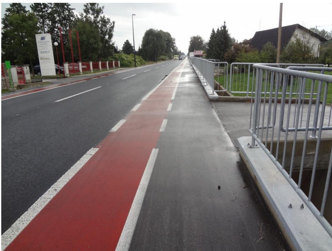
Slika 5-3: Na mestih uvozov in izvozov sta robni črti črtkani.
