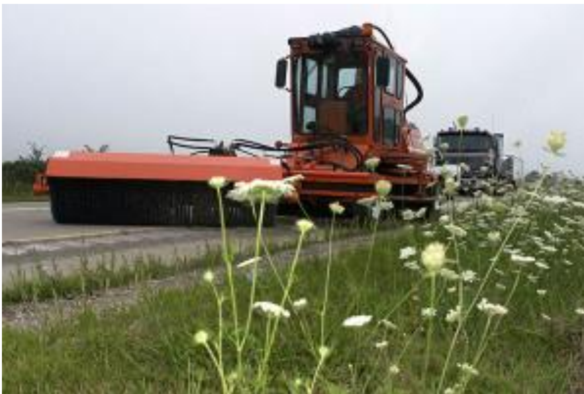
Slika 7-3: Cestni pometač pri čiščenju ropotne črte [13]
