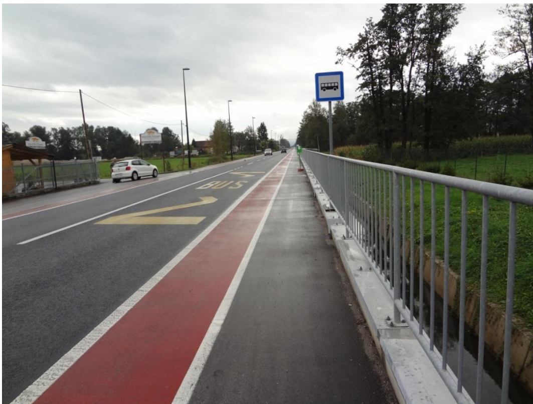
Slika 5-2: Avtobusno postajališče, ki se nahaja na voznem pasu. Prometni znak, ki obvešča tudi kolesarje, da se nahajajo v območju postajališča, bi jih moral na to opozarjati, še preden se postajališče začne.
