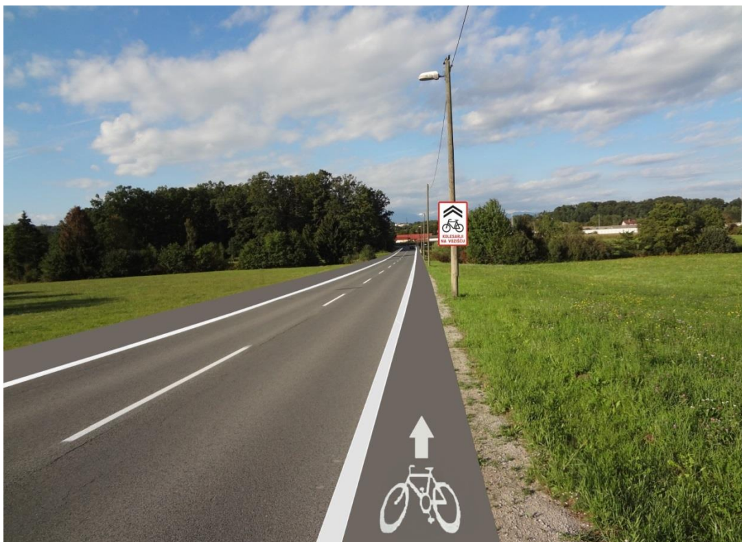
Slika 5-22: Primer osnovno preoblikovane Ceste na Ključ z dvostranskim enosmernim razširjenim robnim pasom
