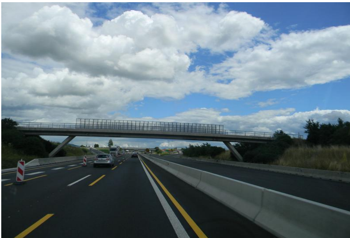
Slika 4-2: Primer tiste vrste ropotne črte, na katero večina najprej pomisli (na sliki bele barve)
