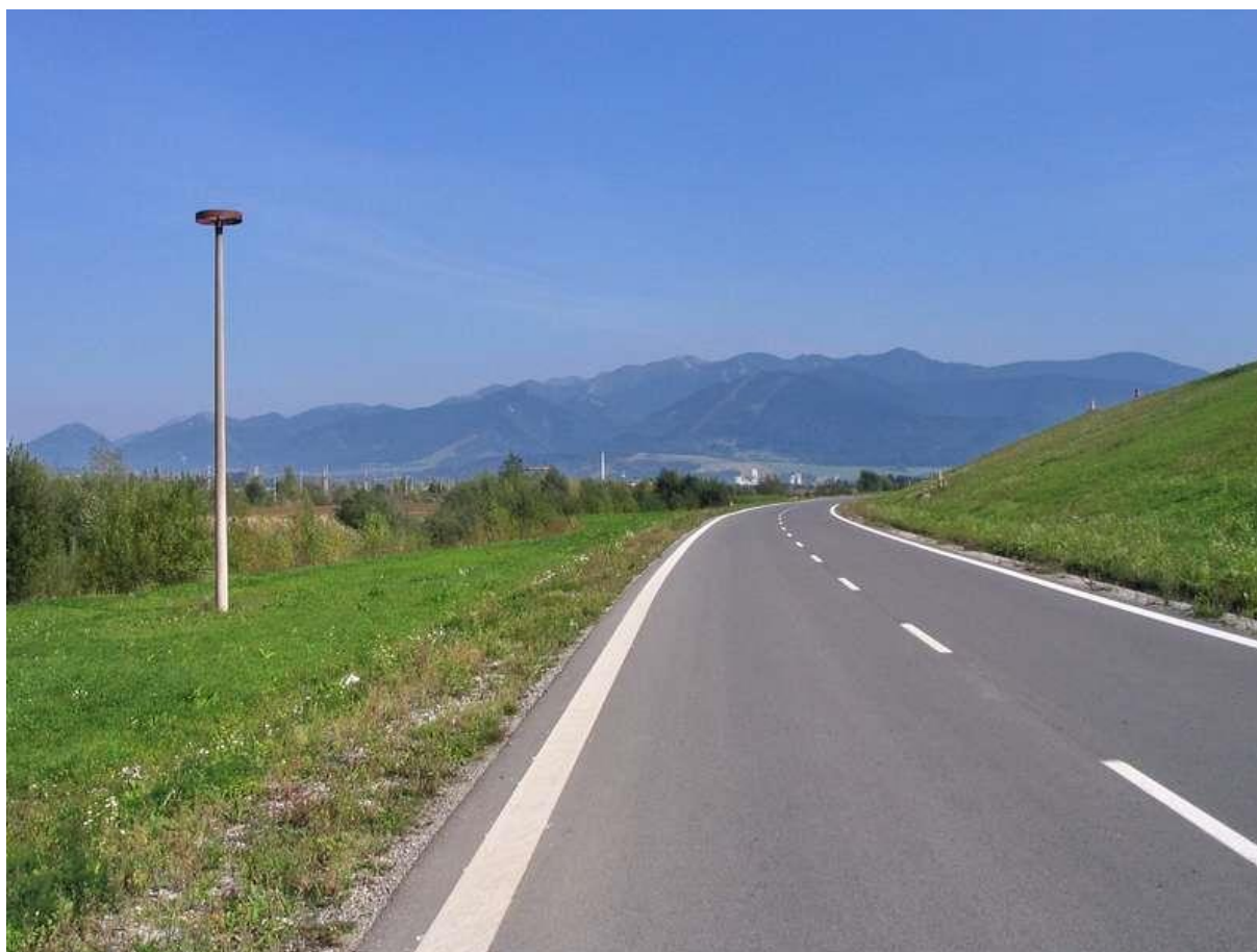
Slika 4-1: Običajen robni pas, od voznega pasu ločen z navadno belo polno talno črto
