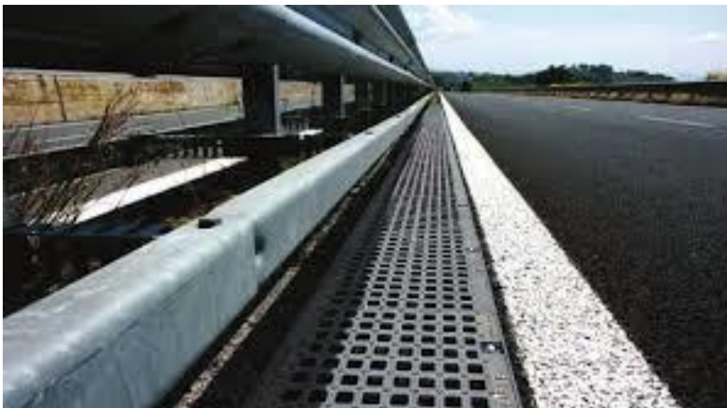
Slika 7-2: Primer dobre prakse vgrajevanja kolesarjem prijaznih rešetk
