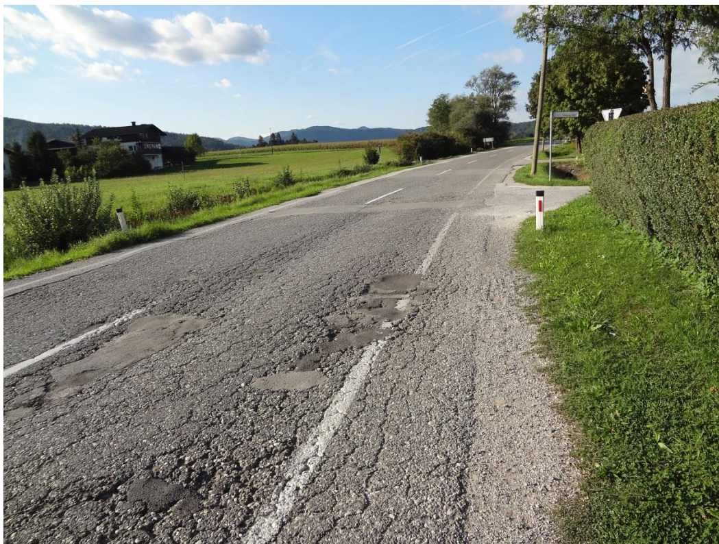
Slika 5-20: Takšna kvaliteta vozne površine je za cestne kolesarje neprimerna in nevarna, četudi je širina robnega pasu ustrezna.
