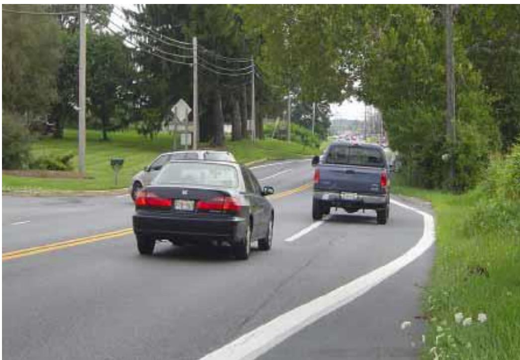
Slika 6-3: Tako imenovani »bypass« oziroma obvozni pas, kjer je robni pas začasno prekinjen in kolesarski promet zato oviran [3].
