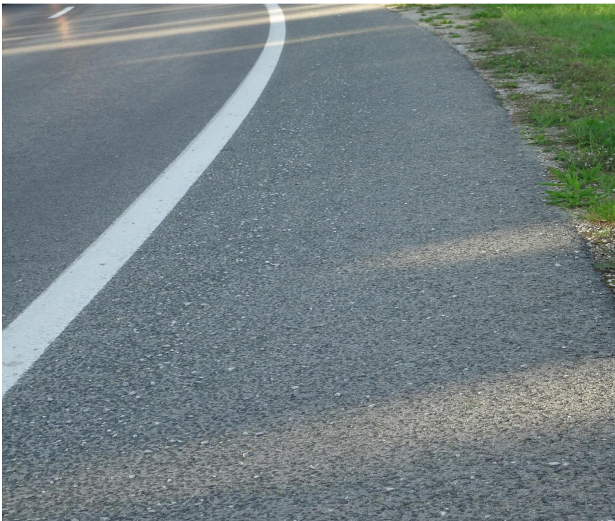
Slika 7-1: S peskom posut razširjen robni pas je za športne kolesarje povsem neprimeren, saj lahko že manjši delci povzročijo kolesarjevo nestabilnost.
