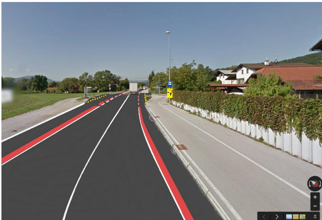
Slika 5-14: Izvedba razširjenega robnega pasu, kjer potekata kolesarska steza in pas za pešce. Prikazano je tudi, kako izvedemo potek pasu na mestu avtobusnega postajališča in ena izmed najbolj ekonomsko smiselnih označb razširjenih robnih pasov, t.j. s širšo rdečo črto (običajno 25 cm) [1] tik ob ropotni črti (Google maps, 2013).
