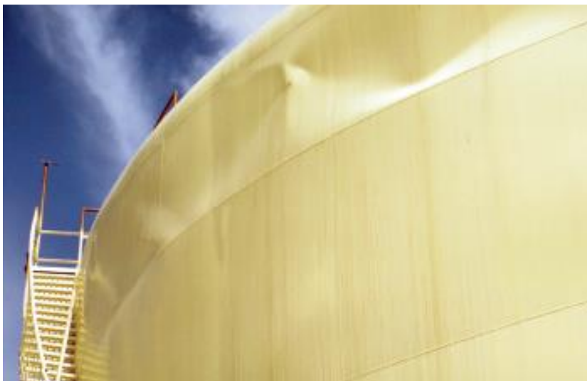
Slika 1: Pretežno elastičen uklon stene rezervoarja pri vrhu.
