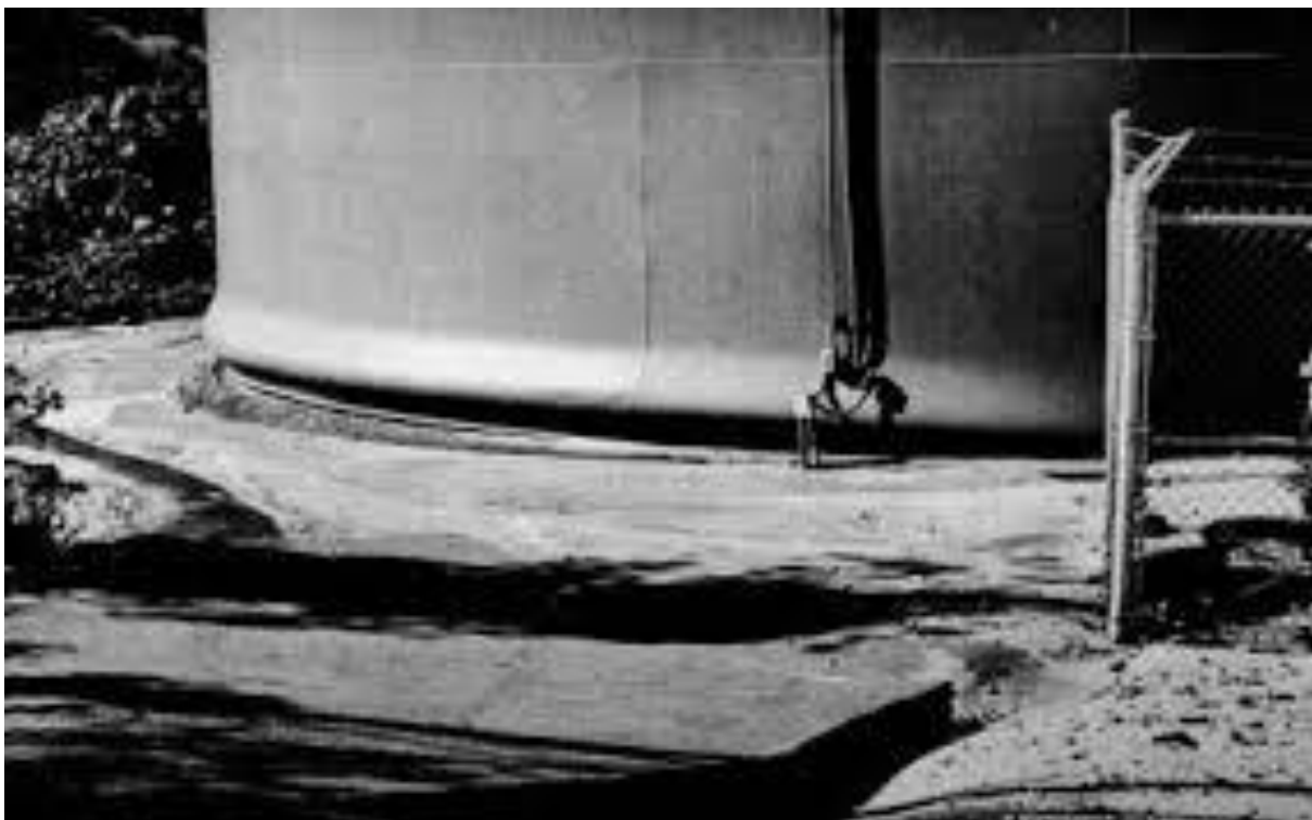
Slika 3: "Slonova noga" pri dnu rezervoarja.
