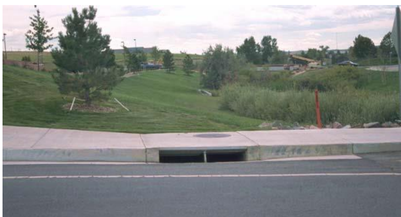
Slika 19: Cestni požiralnik v robniku, postavljen v depresijski točki ob robniku (UDFCD, 2008)
