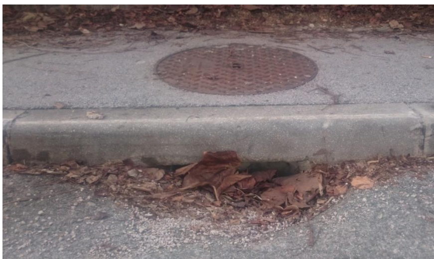
Slika 21: Zamašitev požiralnika (foto: Žagar, 2016)
