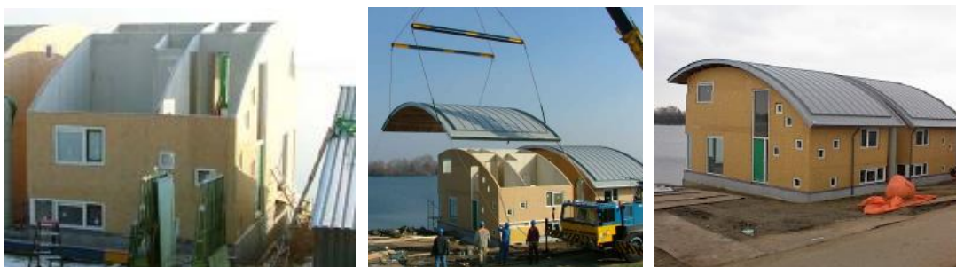
Slike 17: Lahka lesena konstrukcija amfibijskih zgradb v Maasbommel (Prosun, 2011: str. 39; 2x Project review, 2011: str. 9)
