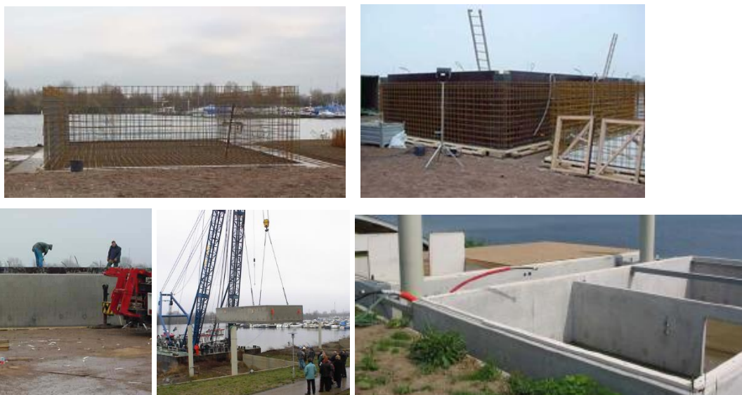
Slike 15: Potek gradnje armirano betonske školjke za amfibijske hiše v Maasbommel: postavitev armature; postavitev kovinskega opaža; končni izdelek; premik školjke z žerjavom; nameščen temelj na lokaciji (Prosun, 2011: str. 39; 3x Project review, 2011: str. 7; Prosun, 2011: str. 39)
