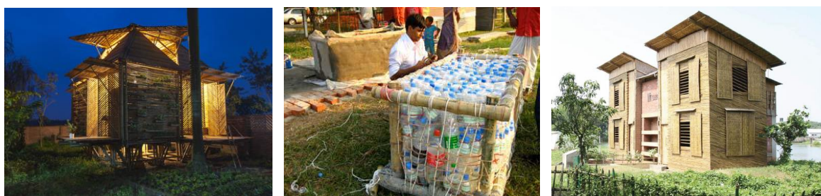
Slike 2: Blooming Bamboo Home v Vietnamu; plovno telo iz plastenk in bambusa za LIFT House; prototip LIFT House v Daki (Davis, 2013; English, 2009: str. 6; Prosun, 2011: str. 162)
