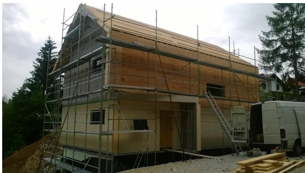
Slika 4: Lumar hiša Primus-D 150 v izgradnji (vir: LUMAR IG d.o.o.)
