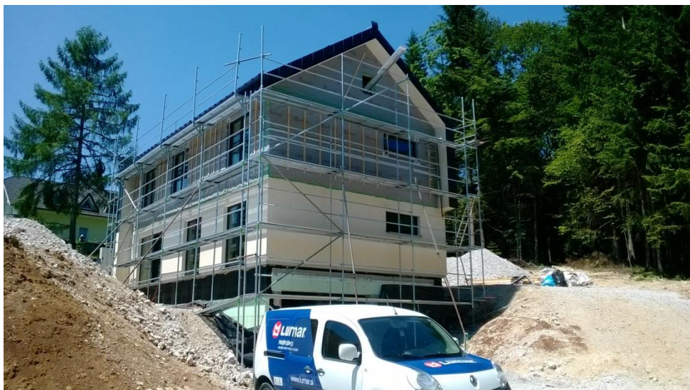
Slika 3: Lumar hiša Primus-D 150 v izgradnji (vir: LUMAR IG d.o.o.)
