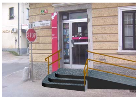
Slika 32: Zamenjava visokih stopnic z nižjimi in bolj udobnimi, dograditev klančine in postavitve ograj.
