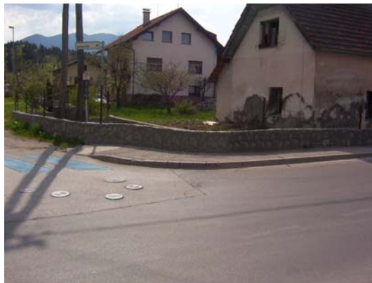
Slika 52: Predlog ureditve križišča: popravljena ograja na mostu, poglobljen robnik in narisana zebra za označitev prehoda za pešce, s čimer se olajša gibanje invalidov ter poveča njihova varnost pri prečkanju ceste.
