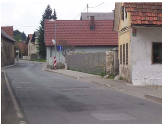
Slika 49: Zaradi hiše v ozadju se prekine ustrezna širina pločnika na Baniji. Pri sprednji hiši bi namesto dvignjenega kratkega dela pločnika lahko bil položen le robnik, kot je izvedeno tudi na sliki 40, ali zaščitna ograja na mestu robnika.
