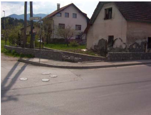
Slika 51: Skupina nevarnosti na križišču ceste Zabrv in Gasilske ulice: pokrovi infrastrukturnih vodov so izven nivoja cestišča, pločnik je brez poglobitve robnika, na mostu je porušena ograja, križišče je brez zebre.
