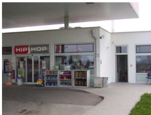
Slika 22: Dostopni prostori bencinskega servisa. Oviro predstavljajo le police pod nadstreškom pred stavbo, ki invalidom in ostalim onemogočajo prehod po pločniku.
