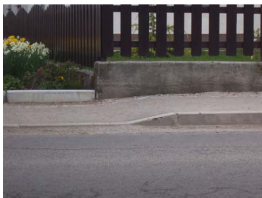
Slika 46: Ustrezen naklon pločnika omogoča lažje gibanje gibalno oviranih ljudi.
