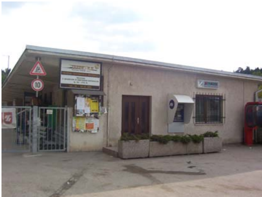
Slika 36: Pogled na stavbo trgovine z gradbenim materialom še s parkirišča.
