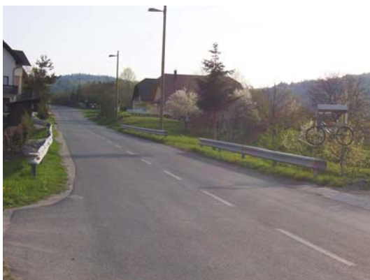
Slika 59: Glavna cesta skozi naselje potrebuje pločnik vsaj na eni strani cestišča. Dobro je, da so z ograjami zavarovani kritični deli ceste.
