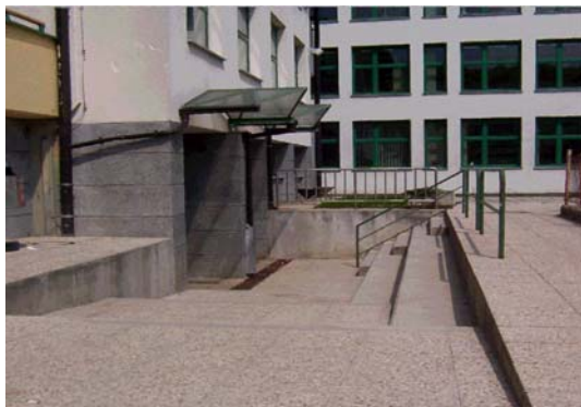
Slika 29: Stopnišče pred južnim vhodom v osnovno šolo.
