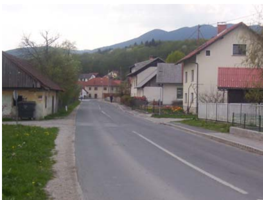
Slika 47: Na delu Ljubljanske ceste manjka pločnik na eni strani ceste, zato predstavlja ta del ulice nevaren odsek za vozičkarje.
