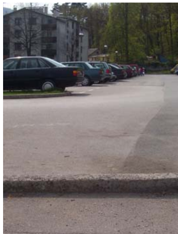
Slika 40: Robnik med parkiriščem stanovanjskih blokov in cesto do industrijskega obrata Kig preprečuje vožnjo avtomobilom, onemogoča pa tudi prehod vozičkarjem.
