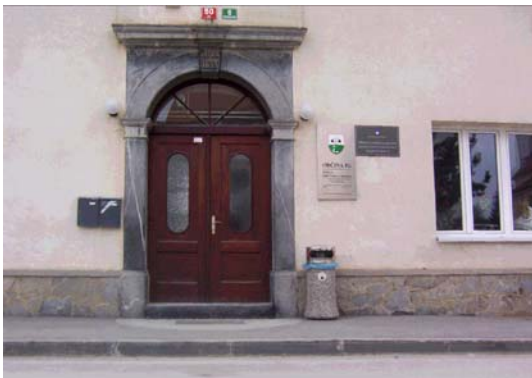
Slika 23: Vhod v stavbo občinske uprave, ki ga ovira visoka stopnica. Zaradi urejenih poglobitev robnikov pločnika je dostop na pločnik pred objektom za vozičkarje možen tako levo kot desno od tega vhoda v stavbo.
