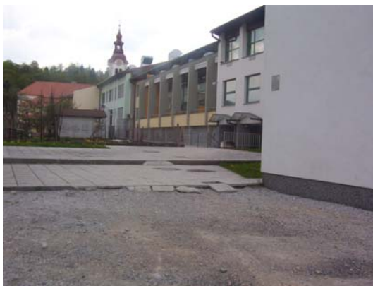
Slika 27: Nedokončana ureditev okolice osnovne šole.
