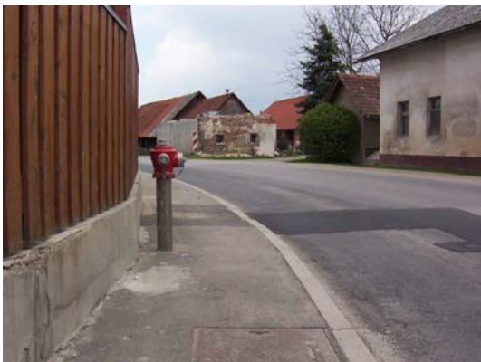
Slika 43: Hidrant na že tako ozkem pločniku.
