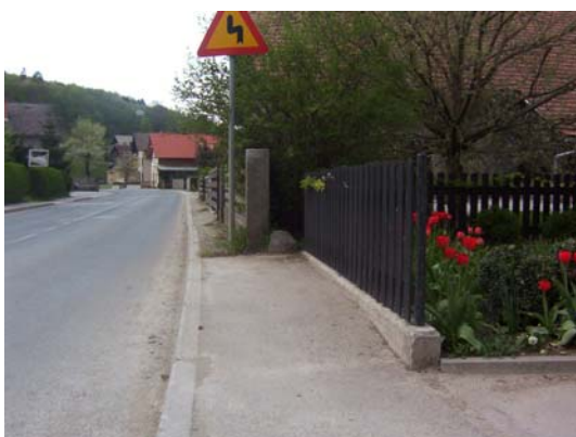
Slika 53: Prekinjen pločnik zaradi ograje, segajoče v prostor pločnika.
