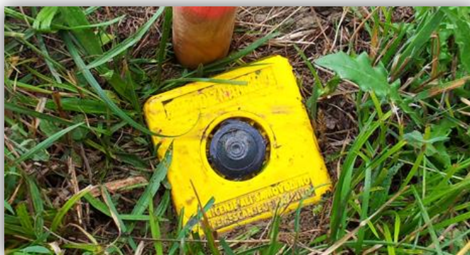
Slika 6: Plastificirana betonska glava s kovinskim sidrom
