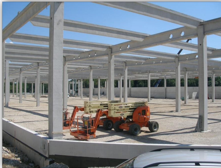
Slika 5: Skelet oziroma ogrodje objekta montažne gradnje Vir: Osebna zbirka
