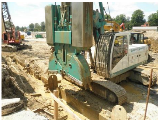
Slika 38: Bager z grabežno žlico za izkop AB diafragme (ELEA iC, 2014)
