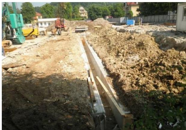
Slika 35: Vodilni kanal diafragme (ELEA iC, 2014)
