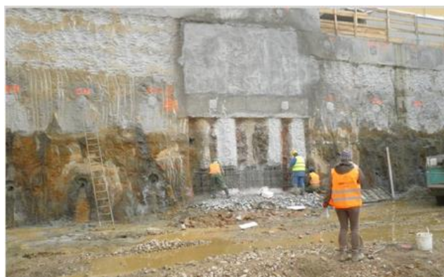
Slika 43: Sidranje na tretjem nivoju sider (ELEA iC, 2014)
