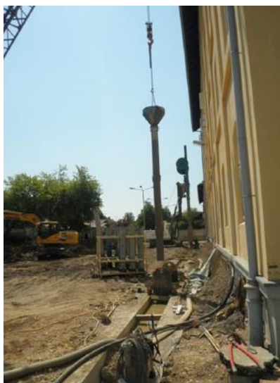
Slika 40: Kontraktorsko betoniranje lamele diafragme (ELEA iC, 2014)
