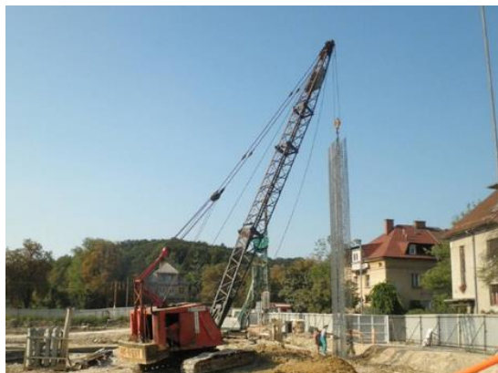
Slika 39: Vgradnja armaturnega koša (ELEA iC, 2014)
