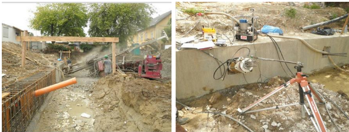
Slika 42: Vrtanje sidrnih vrtin na zgornjem nivoju (levo) in napenjanje 4 vrstnih začasnih geotehničnih sider (desno) (ELEA iC, 2014)
