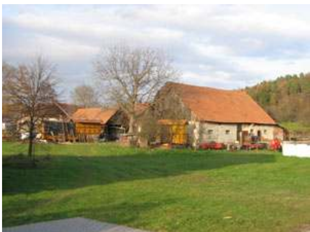
Slika 13: Primer slabo ohranjenega objekta.
