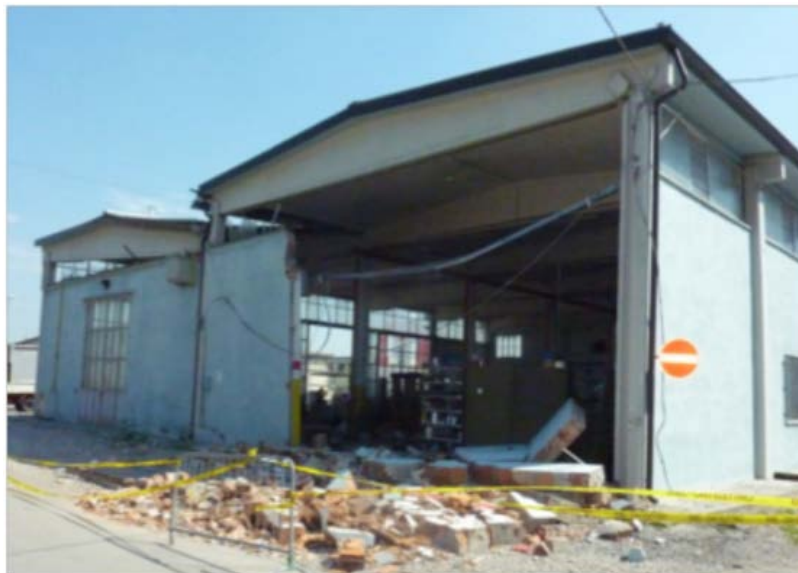
Slika 2: Potres v Emilii - Romagniji leta 2012 in porušitev fasadnega panela
