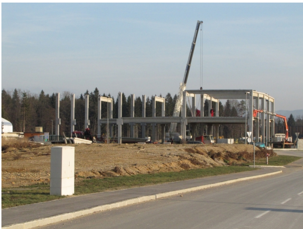
Slika 1: Gradnje montažne hale v Sloveniji (vir: Gradbeništvo Glogovič)
