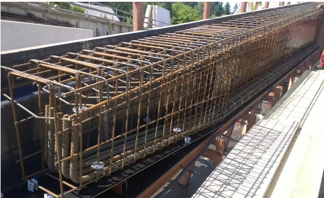
Slika 46: Prikaz armiranja strešnega A - nosilca
