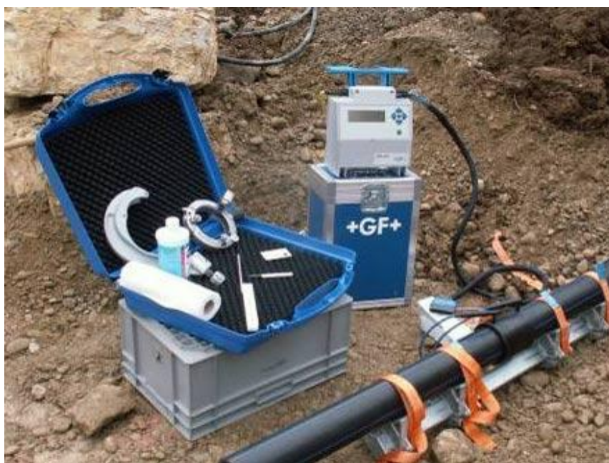
Slika 23: Elektrouporovno varjenje PE cevi
