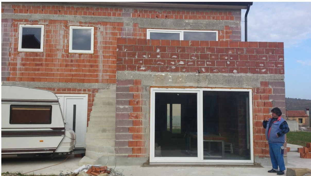
Slika 5: Pogled na obravnavano stanovanjsko stavbo z južne strani
