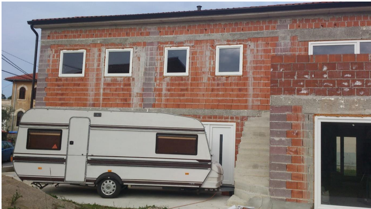
Slika 5.1: Pogled na obravnavano stanovanjsko stavbo ravno tako z južne strani
