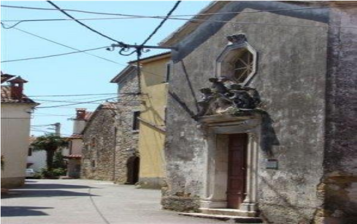
Slika 2.1: Povezovalna cesta v Koštaboni, desni pogled (Zelenko, 2014)
