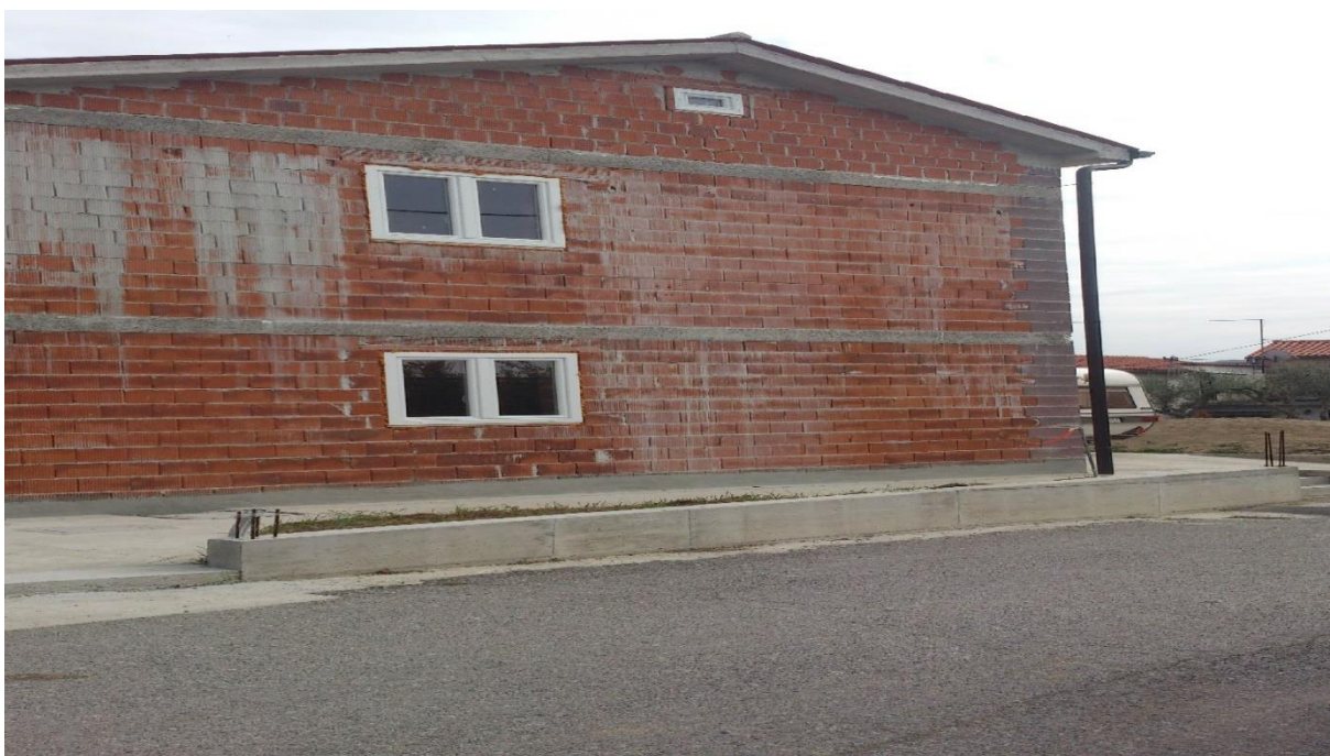
Slika 10: Pogled na obravnavano stanovanjsko stavbo z zahodne strani
