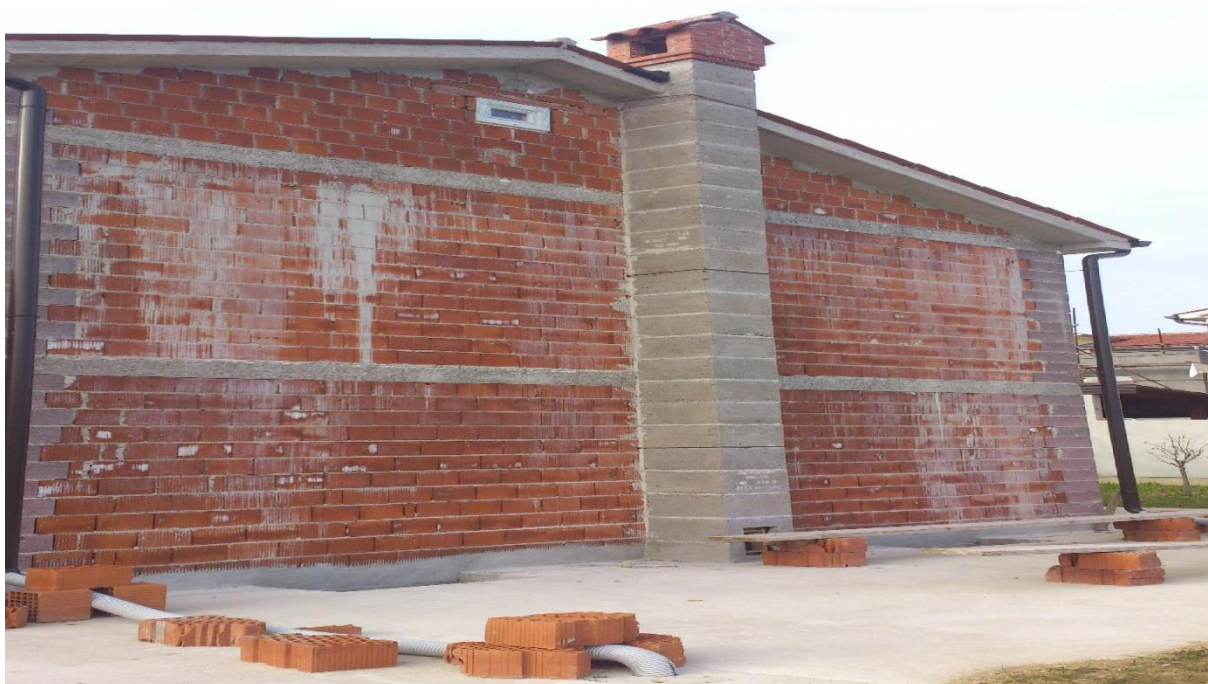
Slika 7.1: Pogled na obravnavano stanovanjsko stavbo prav tako z vzhodne strani
